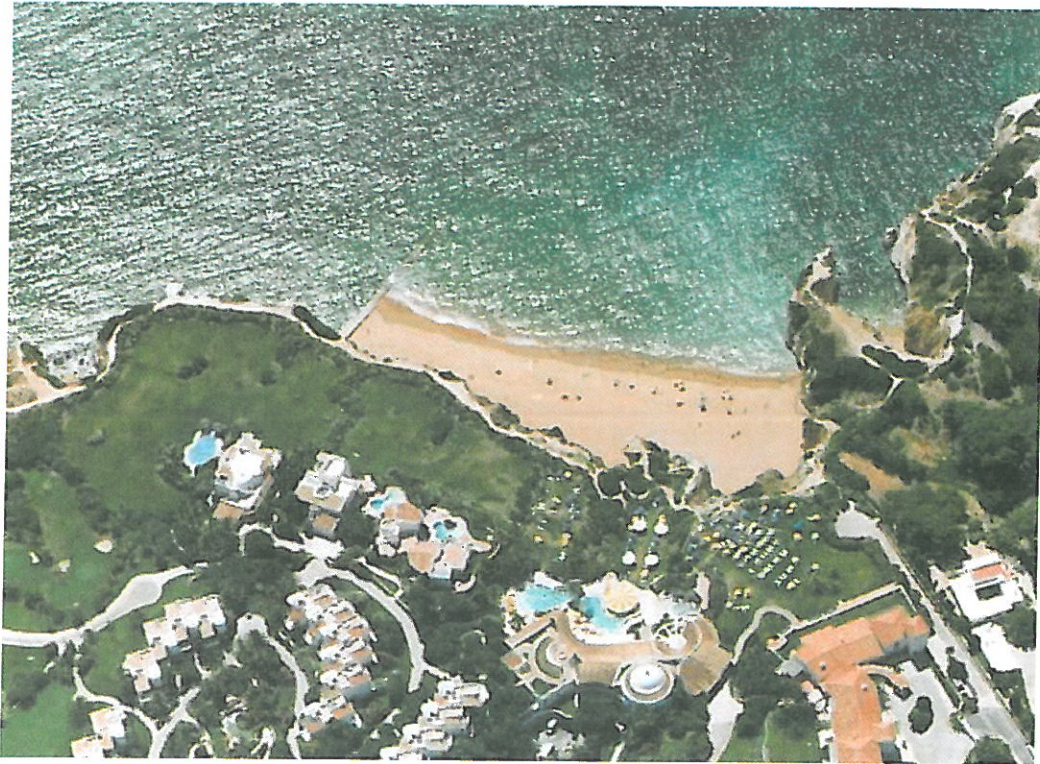
Fig. 7 - Vista da praia e da estrutura de retenção em preia-mar.
