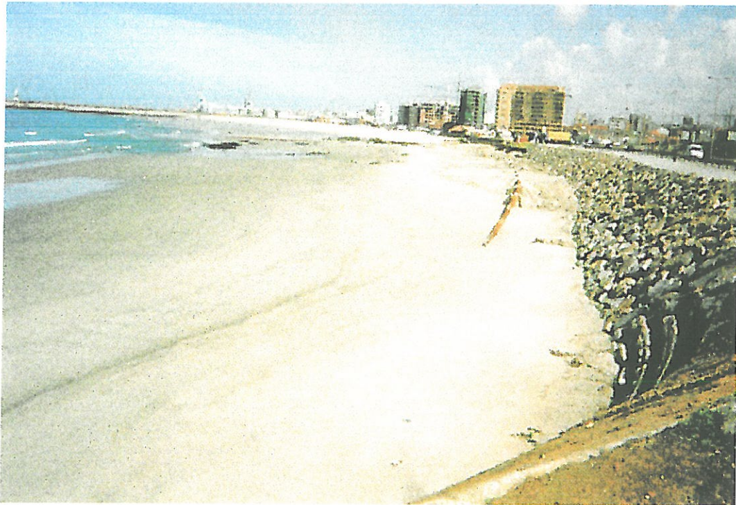
b) – Situação após enchimento
