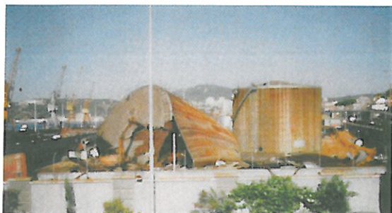
Início dos trabalhos de demolição em Fevereiro de 1997
