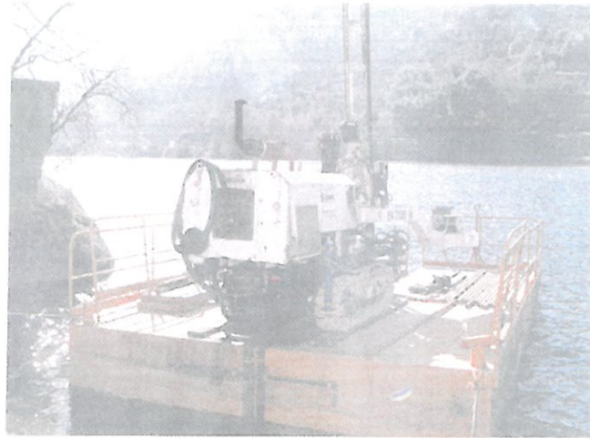
Figura 4 – Aspecto da sonda montada sobre a plataforma flutuante.
