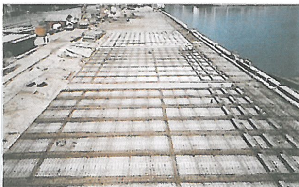
Vista geral das obras de reabilitação do cais de 300m
