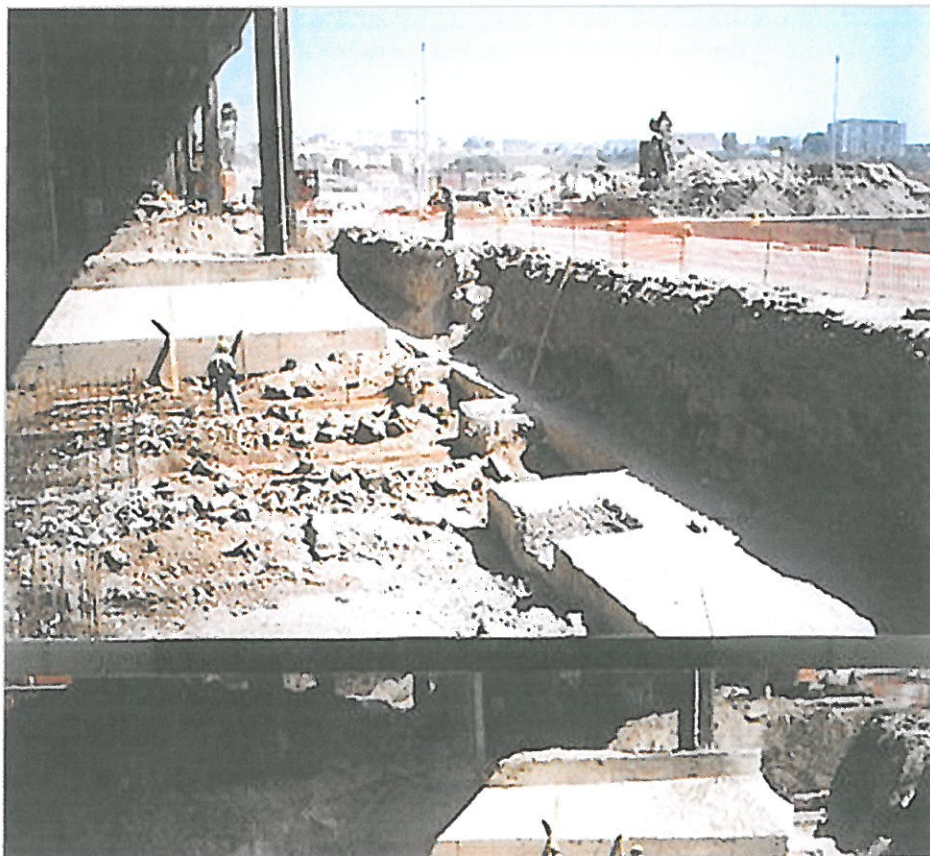
Vista da construção das obras de reabilitação do cais Nascente
