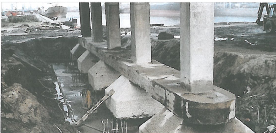
Reforço das fundações do viaduto
