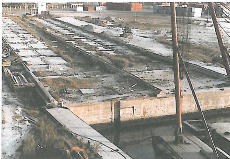
Vista do estaleiro de pré-fabricação dos blocos
