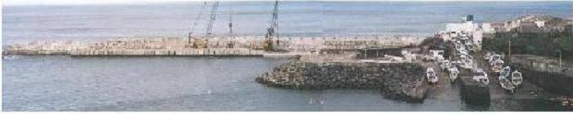
a) Vista de cima da falésia para norte.
