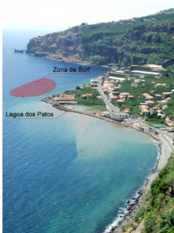
Figura 2 – Vista Aérea do Local de Implantação da Marina
