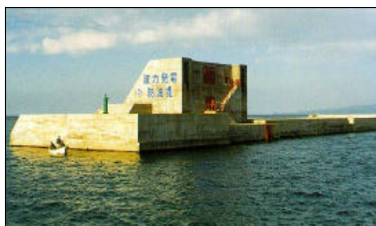
Fig. 10 Projectos de demonstração de energia das ondas do tipo CAO integradas em quebra-mares, Graw (2001). Porto de Vizhinjam (esquerda) e Porto de Sakata (direita).
