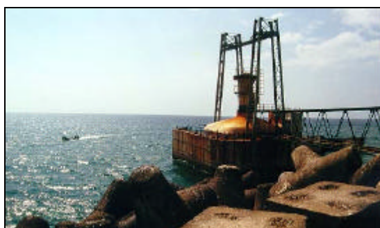
Fig. 10 Projectos de demonstração de energia das ondas do tipo CAO integradas em quebra-mares, Graw (2001). Porto de Vizhinjam (esquerda) e Porto de Sakata (direita).
