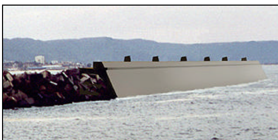
Fig.9 Central de Energia das Ondas “LIMPET” na Ilha de Islay, Escócia (WAVEGEN, 2001). Vista traseira (esquerda) e imagem futurista proposta pela empresa WAVEGEN para utilização da central em quebra-mar (direita).
