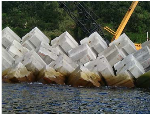
Manto de protecção em blocos Antifer de 200 kN
