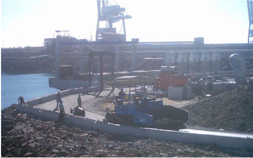
Fig. 18 – Fase de instalação do equipamento e acabamentos.
