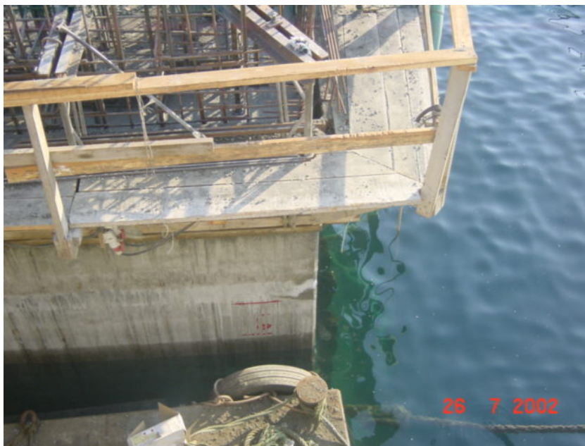
Fig. 11 – Construção em flutuação com o emprego de sistema de cofragem deslizante.
