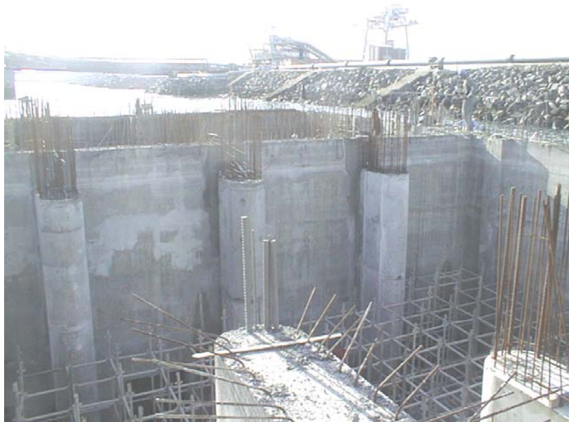
Fig. 17 – Parede interior central após a 2 a fase de construção.
