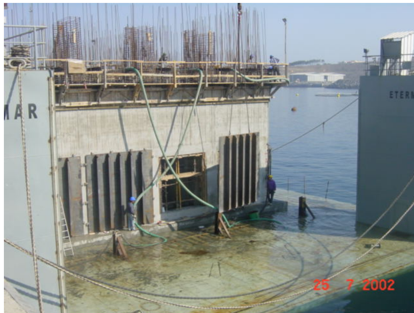
Fig. 9 – Construção das paredes na plataforma flutuante. Montagem das tampas provisórias para vedação das entradas de água dos canais de admissão.
