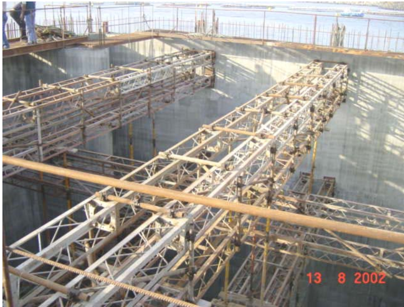
Fig. 12 – Montage de escoras metálicas de contraventamento das paredes exteriores sujeitas aos impulsos hidrostáticos.
