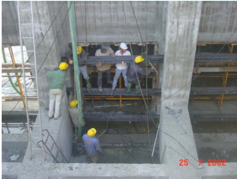
Fig. 10 – Montagem das tampas provisórias observada no interior do caixotão.
