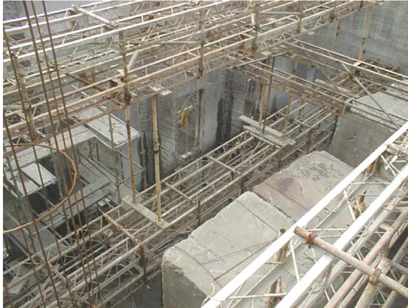
Fig. 14 – Colocação de blocos de betão do tipo “Antifer”, no interior da estrutura, por forma a conferir peso adicional.
