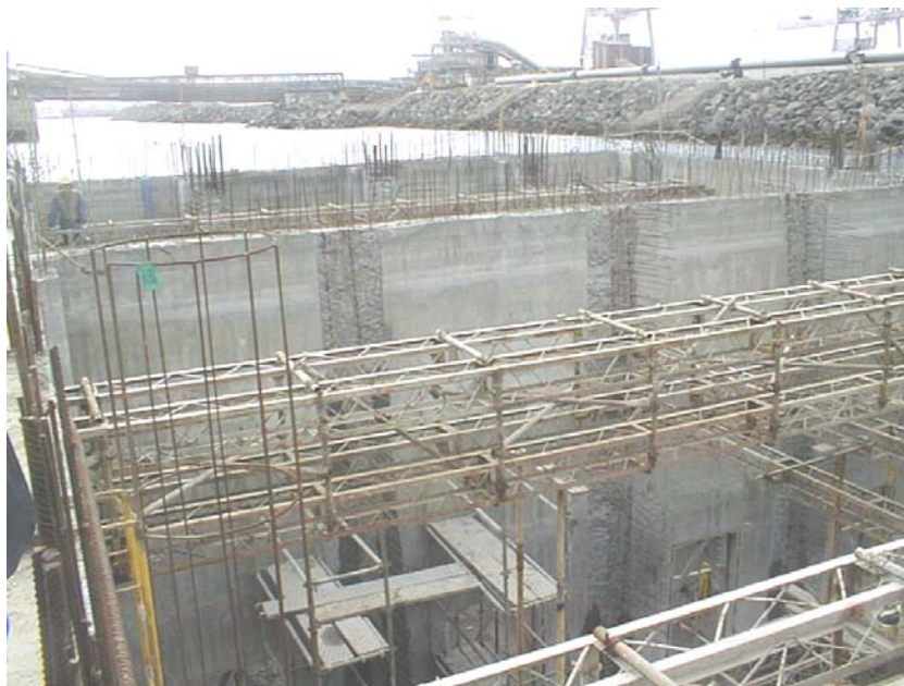
Fig. 16 – Destacamento de armaduras de espera na parede interior central..
