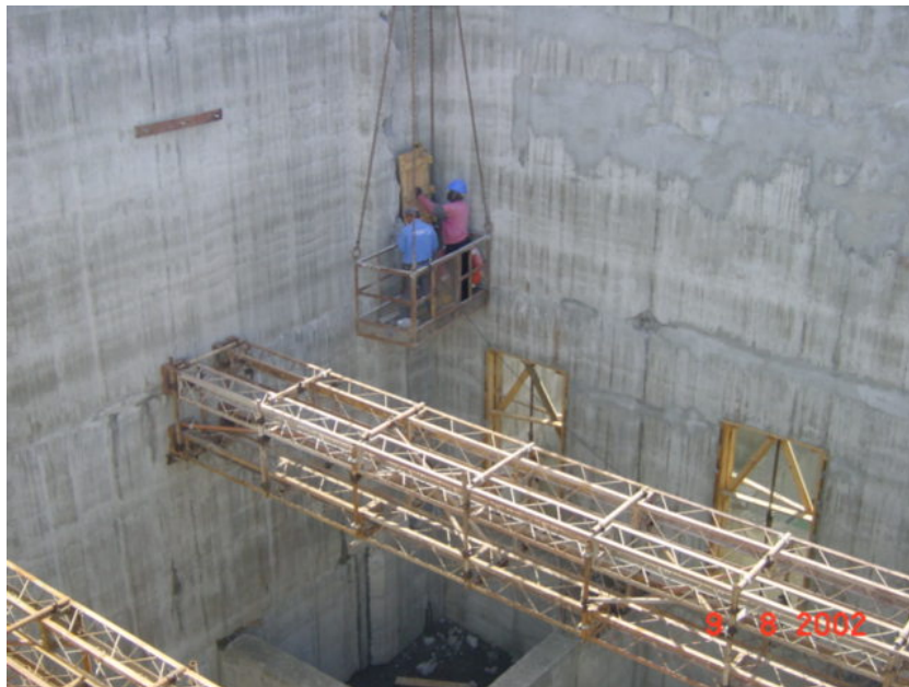
Fig. 13 – Sistema de contraventamento. Trabalhos de montagem.
