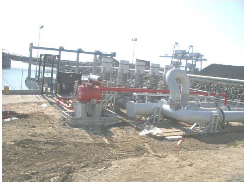
Fig. 1 - Equipamento instalado na superestrutura.
