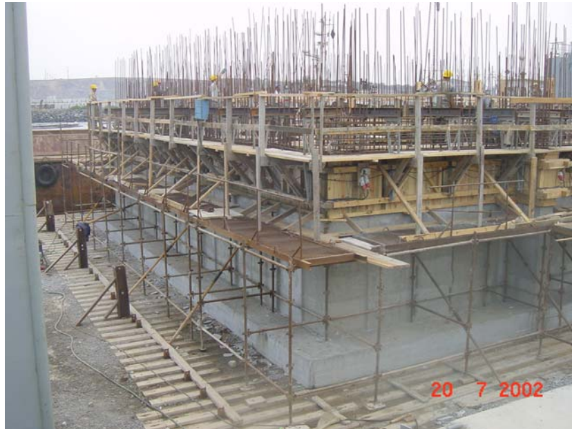
Fig. 8 – Início da construção na plataforma flutuante.
