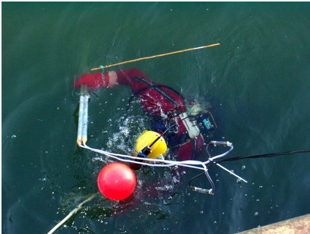
Figura 4: Colocação das cargas de material energético com mergulhador
