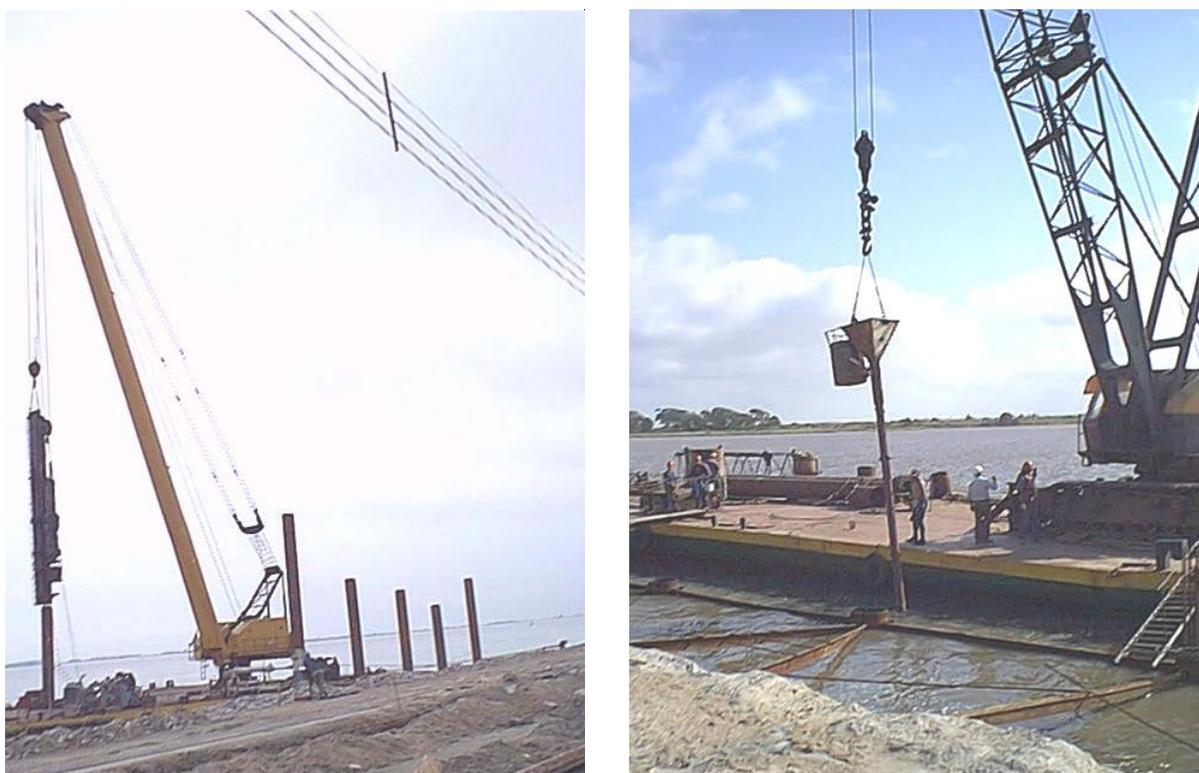
Figura 4 - Cravação e concretagem da estaca
