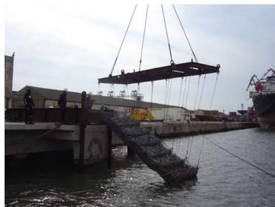
Figura 6. Escavação e colocação do enrocamento no pé do muro
