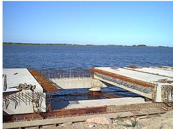
Figura 5. Colocação das vigas pré-moldadas – plataforma do cais
