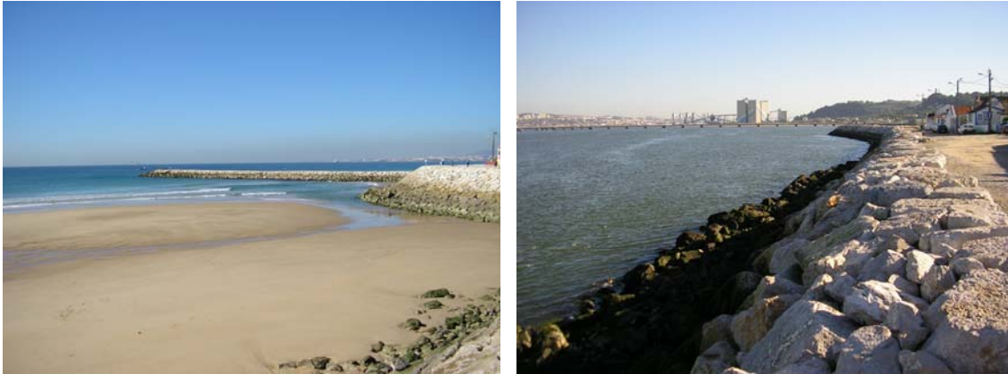
Figura 1. Estrutura marginal porosa da Costa de Caparica.
