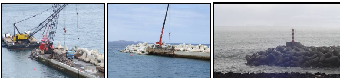
Fotos 6 a 8 – Pormenor da construção da cabeça do Molhe
