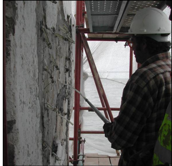
Fig. 6 – Injecção de resina epoxi nas fissuras.
