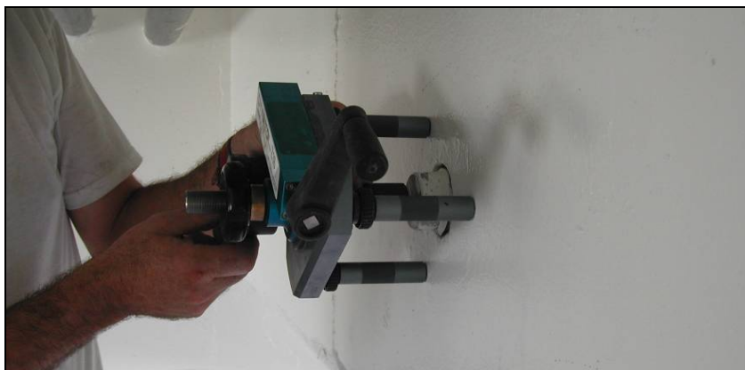
Fig.10 – Equipamento utilizado para os ensaios de aderência
