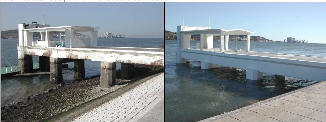
Fig. 13 – Aspecto da estrutura antes e após a reparação
