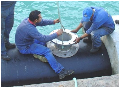
Fotografia 12 – Instalação do orifício
