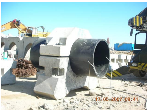
Fotografia 5 – Anel tipo II ( V = 2,19 \text{ m}^3 - Tétouan e V = 2,57 \text{ m}^3 - Tanger)
