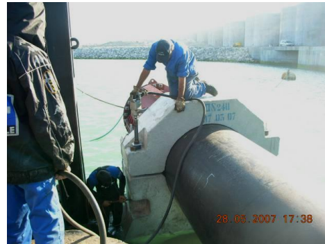
Fotografia 9 – Instalação dos anéis
