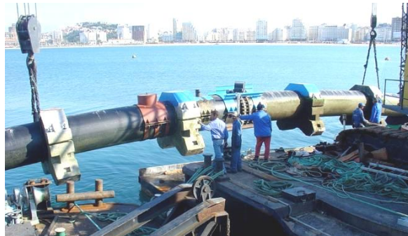
Fotografia 13 – Preparação do difusor para o afundamento do tubo
