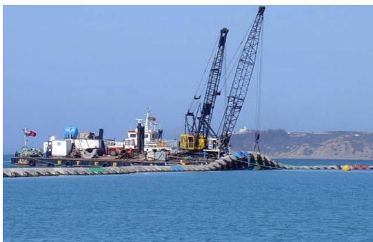
Fotografia 16 – Operação de afundamento
