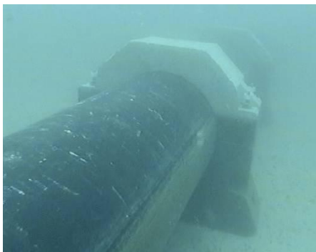
Fotografia 19 – Secção do tubo afundado
