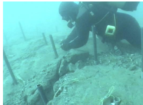
Fotografia 15 – Colocação de explosivos na abertura da vala
