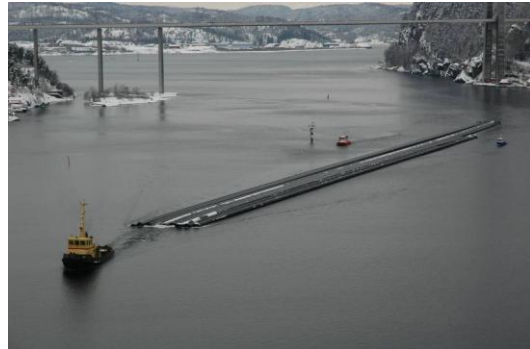
Fotografia 2 – Transporte dos tubos
