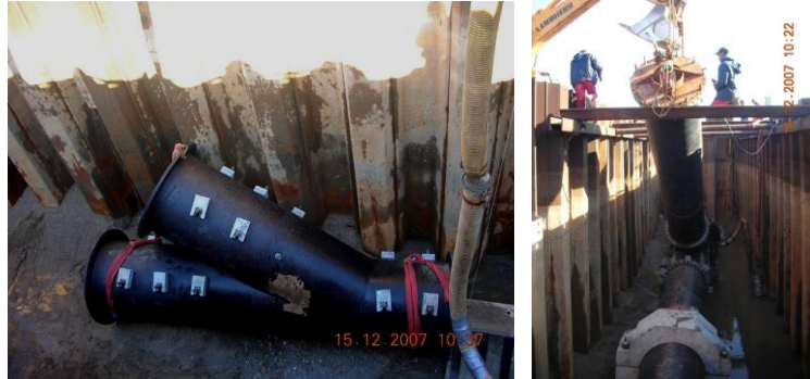
Fotografia 23 – Estrutura em aço para instalação da cápsula de limpeza das tubagens
