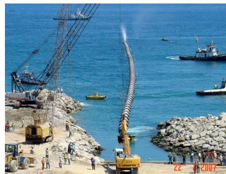
Fotografia 17 – Afundamento na secção em vala
