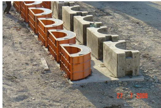
Fotografia 4 – Anel tipo I. Emissário Tanger ( V = 1,62 \text{ m}^3 )
