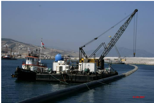
Fotografia 8 – Pontão utilizado na instalação dos anéis
