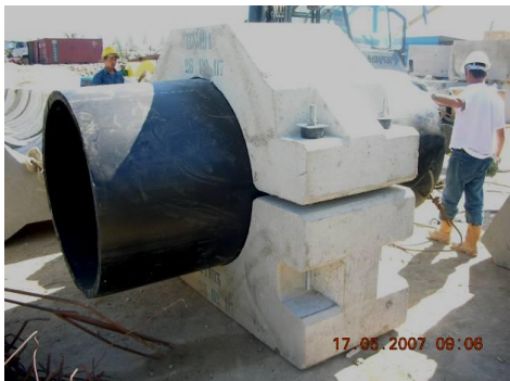
Fotografia 3 – Anel tipo I. Emissário Tétouan ( V = 1,76 \text{ m}^3 )
