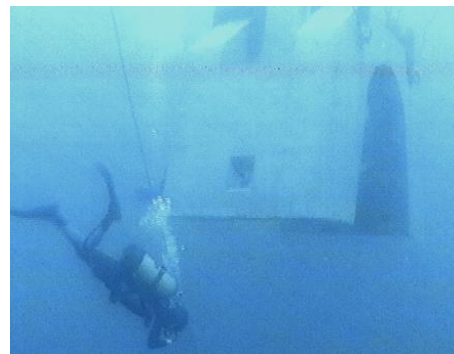
Fotografia 20 – Colocação do estabilizador
