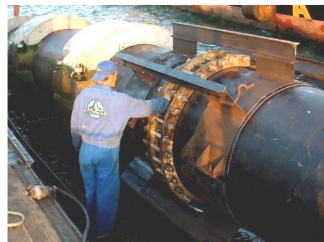
Fotografia 11 – Ligação flangeada. Tanger
