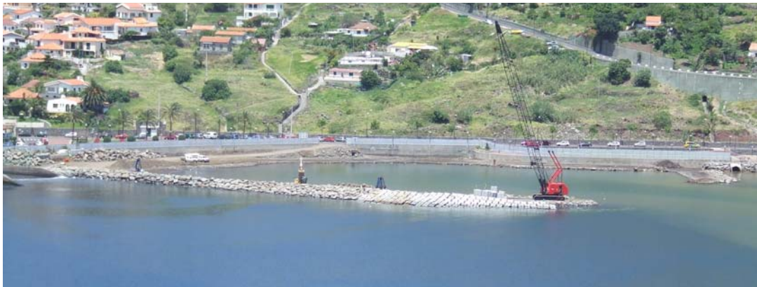
Figura 15 – Construção do esporão principal de abrigo (poente)
