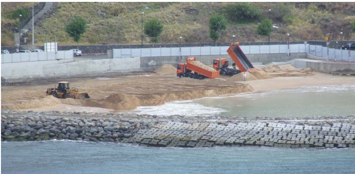
Figura 17 – Enchimento artificial de areia
