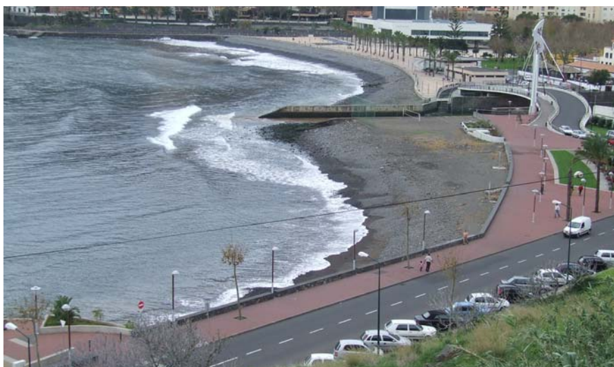
Figura 3 – Local de construção da praia
