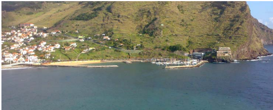
Figura 14 – Vista geral da praia, após construção
