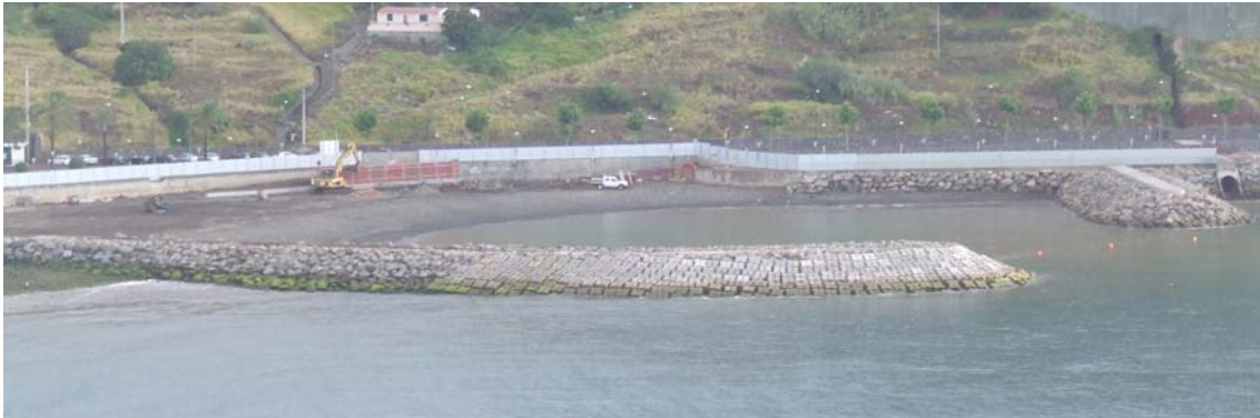
Figura 16 – Esporão principal de abrigo (poente) e obra de remate nascente
