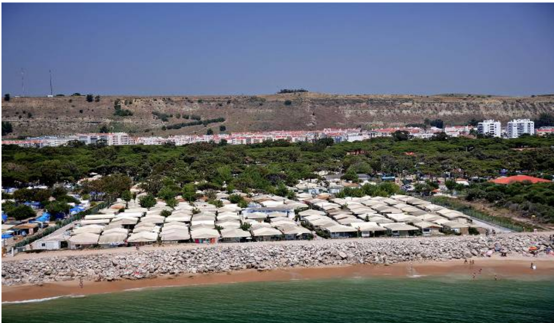
Figura 6. Um dos parques de campismo na praia de S. João em Junho de 2006 protegido pela referida obra de defesa aderente precária, reperfilada em 2007. Ao fundo a arriba fósil. Para quando a desocupação de uma faixa de segurança?
