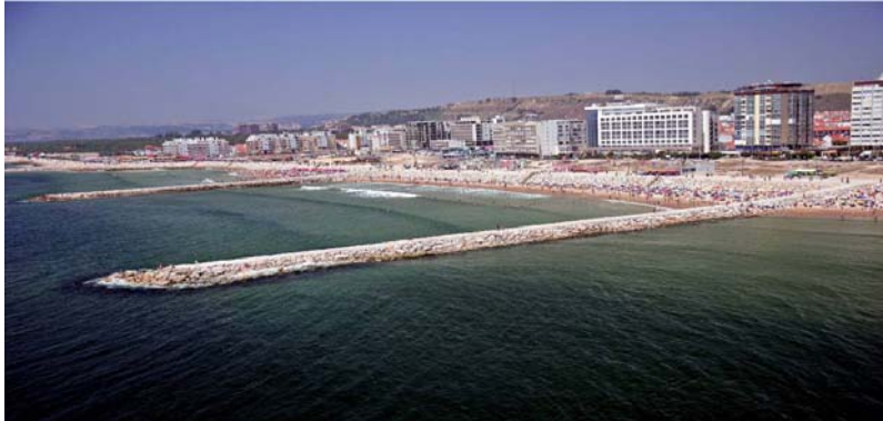
Figura 1. Esporões e obra aderente da frente urbana da Costa da Caparica após a Empreitada de reperfilamento (Junho de 2006).
