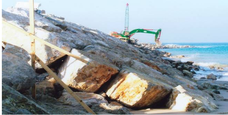
Figura 2. Operação de reperfilamento da obra aderente existente na frente urbana.
