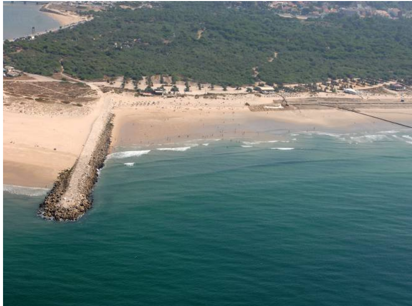
Figura 9. Operações em curso (finais de Agosto 2007) de alimentação artificial com areias, na praia de S. João (troço Norte, junto aos esporões da Cova do Vapor).
