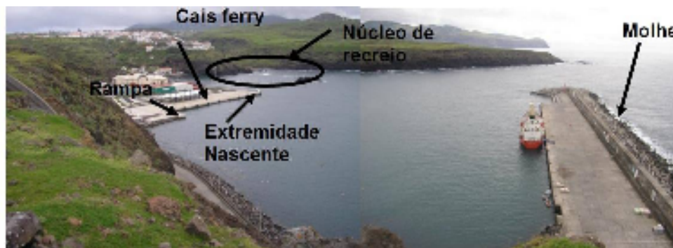
Figura 1 - Porto de Vila do Porto. Cais ferry: Rampa e Extremidade Nascente. Localização do futuro núcleo de recreio (Fortes et al. , 2006).
