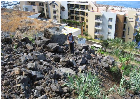
b – Derrocada ocorrida junto ao edifício Onda Parque, vendo-se ao fundo o Hotel Calheta Beach
