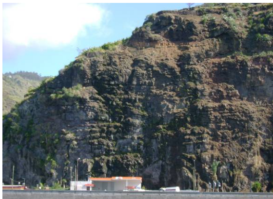
a – Vista do extremo Oeste
