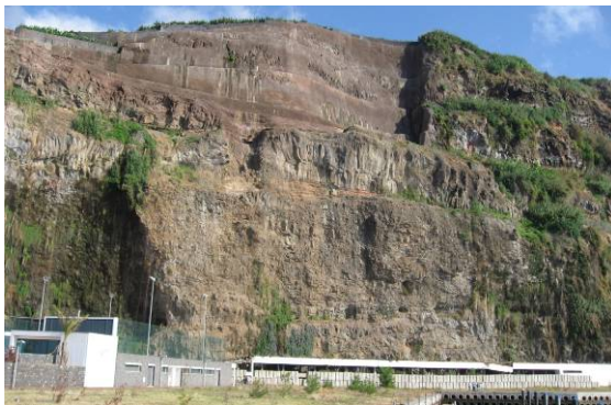
b – Vista da escarpa após a realização dos trabalhos de consolidação
