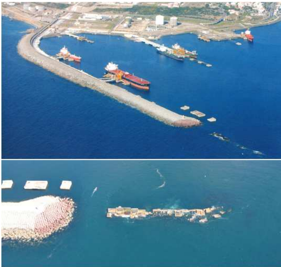
Figura 6: Molhe Oeste do Porto de Sines após os trabalhos de reabilitação terminados em 1992 (incluindo destroços do molhe original)
