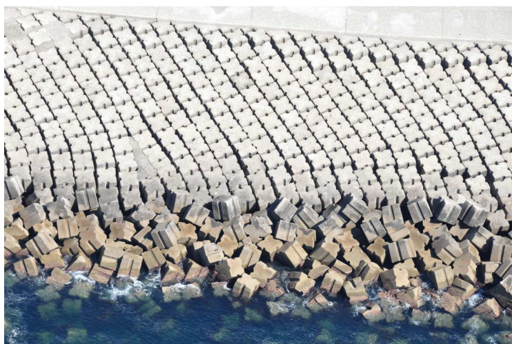
Figura 10: Molhe Oeste de Sines: pormenor do modo de colocação dos blocos Antifer na parte superior do talude exterior e na berma de coroamento
