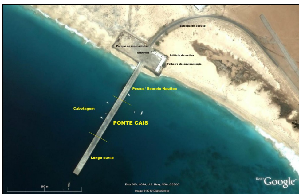
Figura 2 - Porto Inglês – Instalações portuárias
