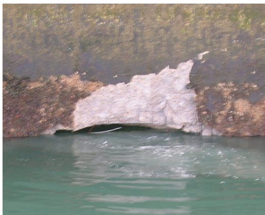
Figura 17 – Região superior do rombo provocado no extradorso do molhe.
