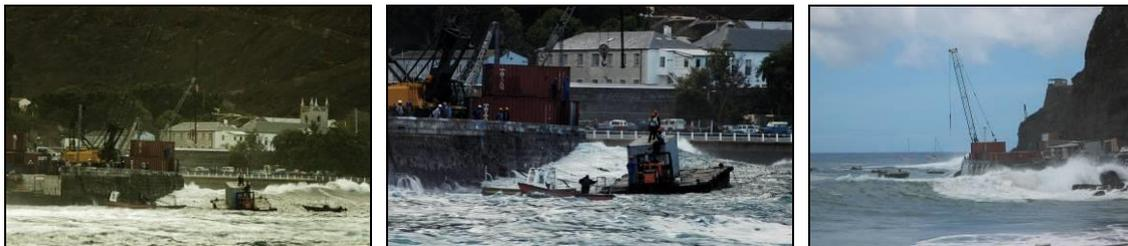
Fotos 10 a 12– Operações de elevação de contentores e carga para o terraplino, durante episódio de ondas de tempestade de NW
