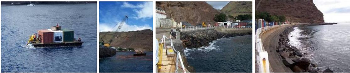
Fotos 6 a 9 – Pontão de contentores e grua, protecção provisória da entrada e restos da protecção da marginal
