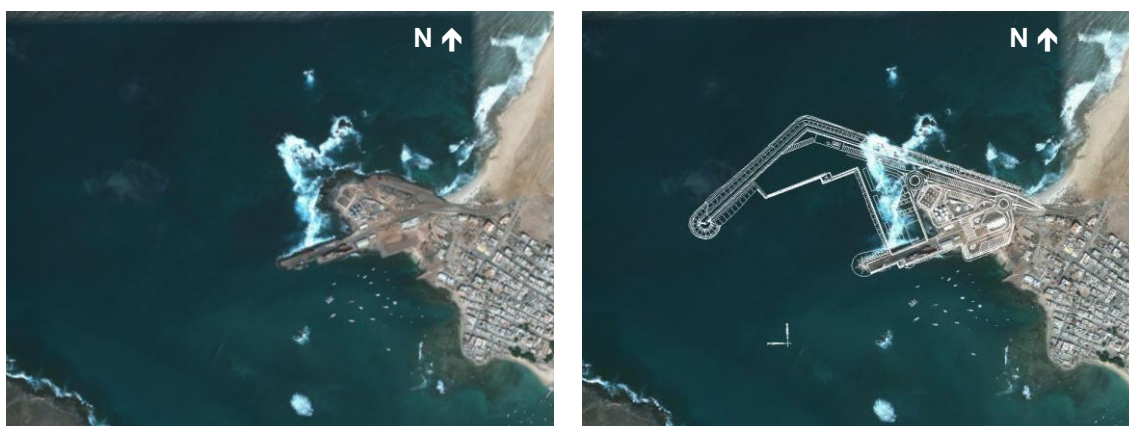
Fig. 5 a) e b) - Fotografia aérea do Porto de Sal-Rei sem (a) e com (b) as novas obras implantadas (extraído do Google Earth)
