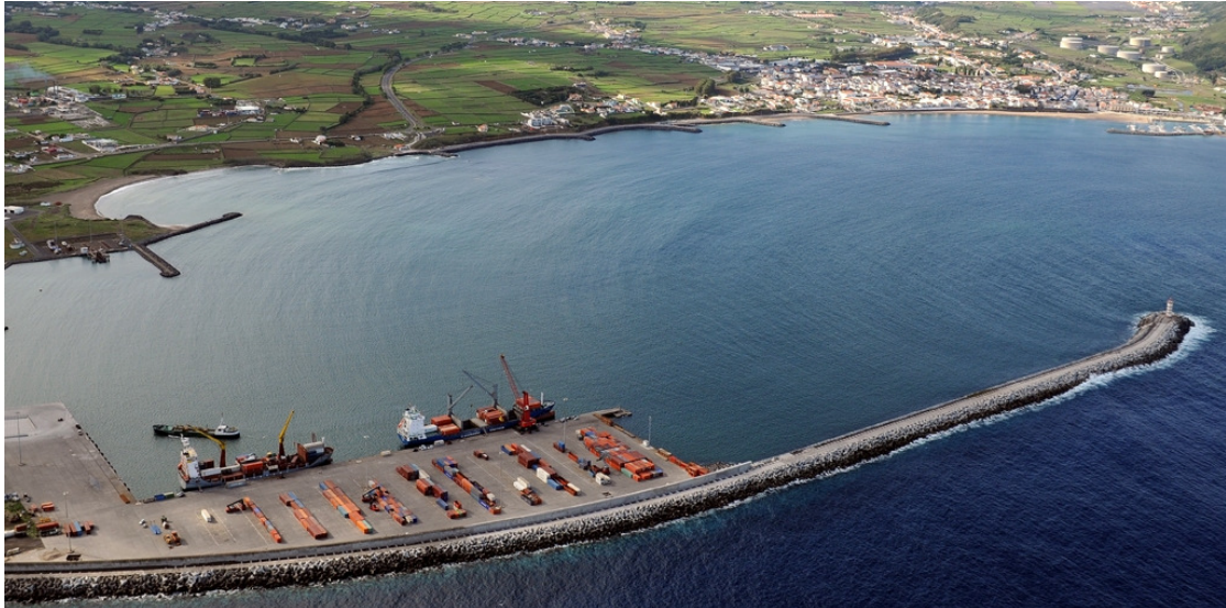
Figura 14 – Vista aérea do Porto da Praia da Vitória com o molhe Sul e o cais 12 em primeiro plano.
