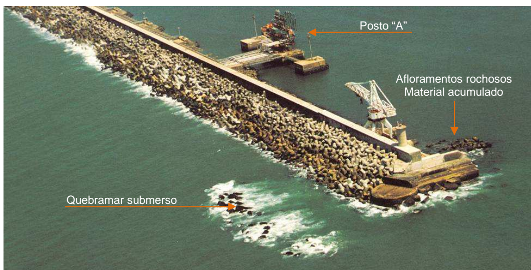
Figura 12 – Extremidade do quebramar norte do Porto de Leixões.
