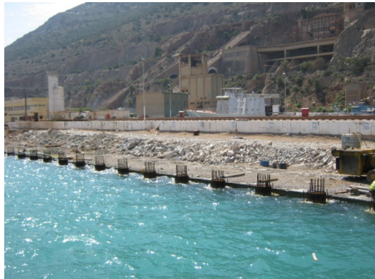
Intervenção de reforço do cais adjacente ao synchrolift .
