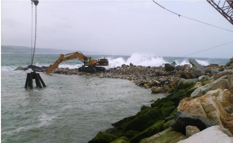
Figura 17 – Remoção dos materiais dispersos no intradorso da cabeça do molhe
