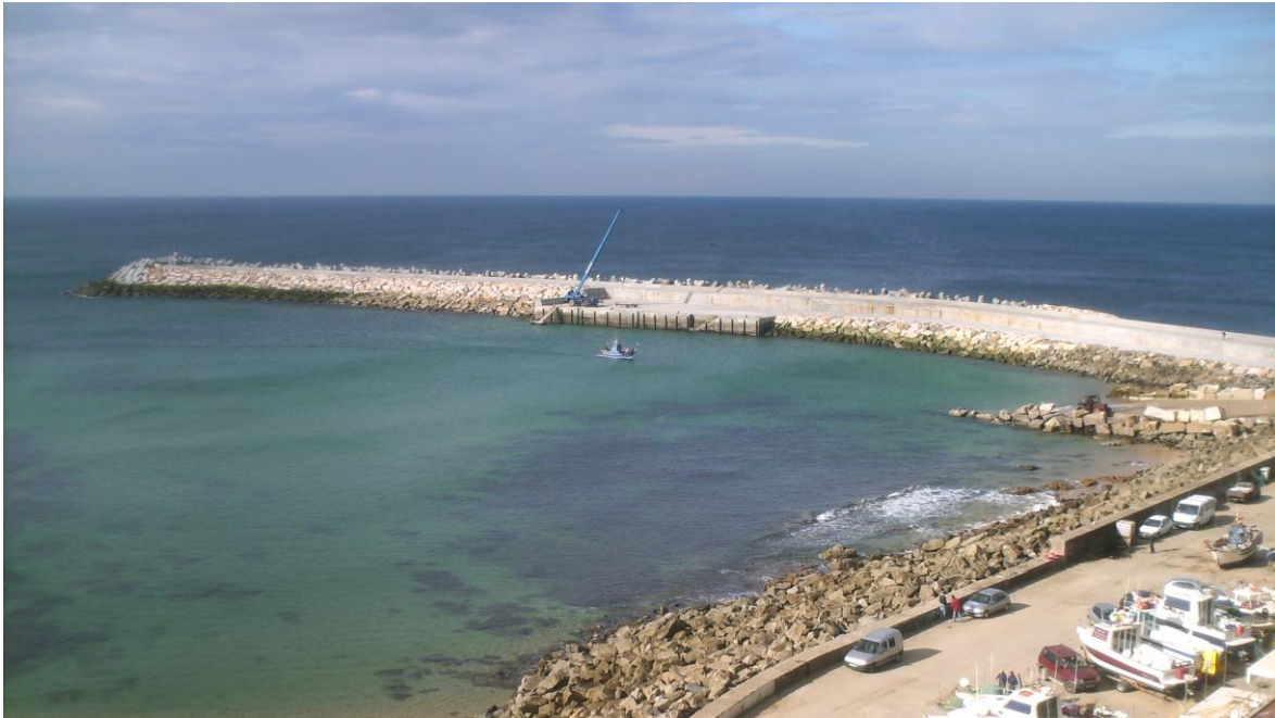
Figura 21 – Vista geral do molhe da Ericeira após a conclusão da empreitada (Dezembro de 2010)
