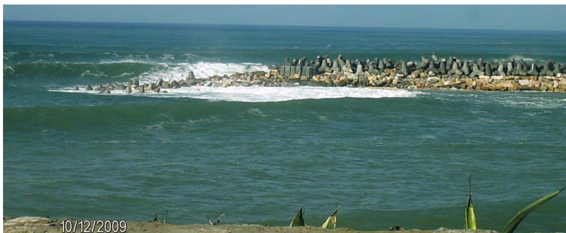
Figura 13 – Zona mais avançada da obra após o temporal de 9 e 10 de Dezembro de 2009
