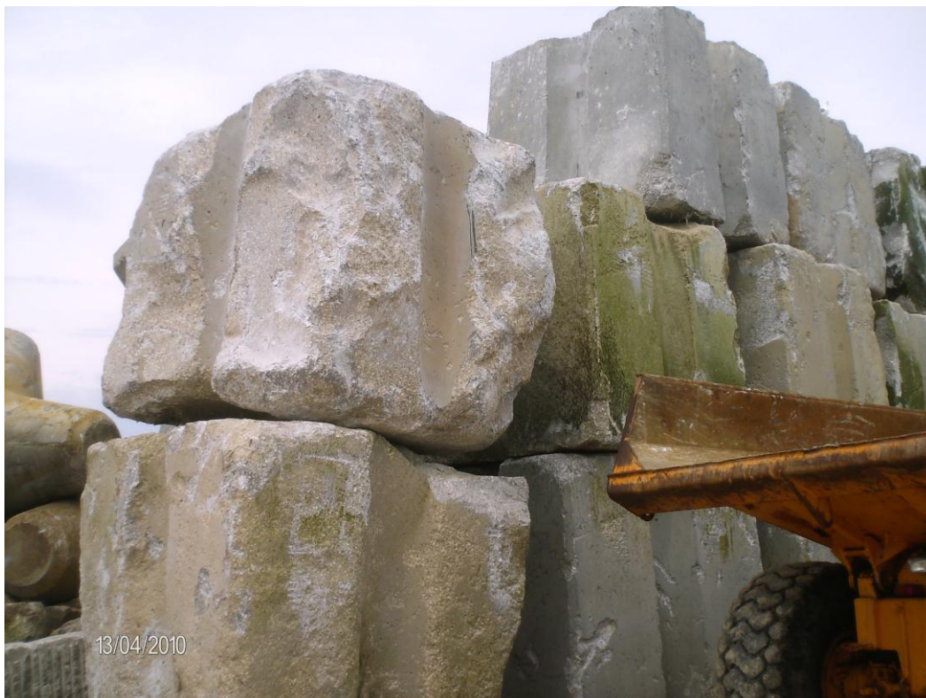
Figura 19 – Blocos Antifer de 400 kN danificados
