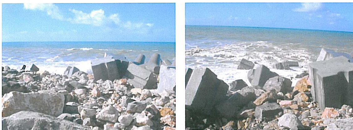
Figura 14 – Materiais dispersos no intradorso da cabeça do molhe
