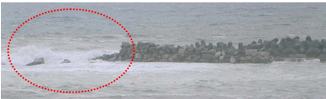
Figura 12 – Arrasamento da parte mais avançada da obra
