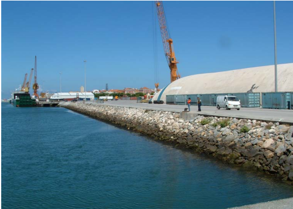
Figura 2 – Porto da Figueira da Foz. Zona de construção do prolongamento do Cais de Granéis Sólidos. Em primeiro plano vê-se o Cais de Granéis Sólidos; ao fundo o Cais Comercial.
