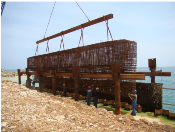
Figuras 27 e 28 – Execução da viga de coroamento do Cais 1 (Maio 2009)
