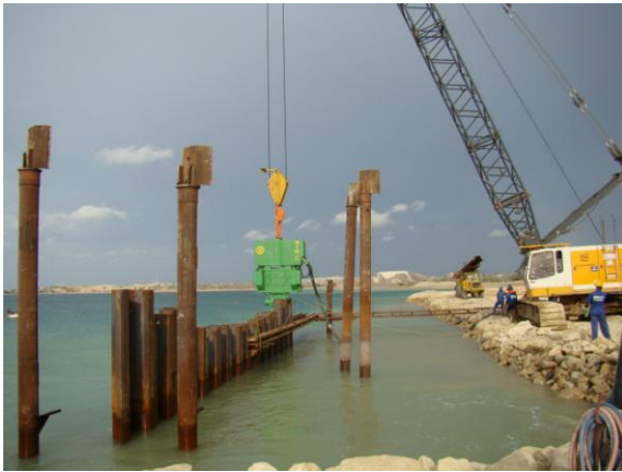
Figuras 25 e 26 - Início da cravação da cortina principal do Cais 1 (Fev. 2009) e instalação de tirantes (Março 2009).
