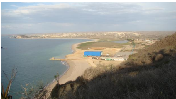
Figura 3 - Vista da zona de implantação das obras
