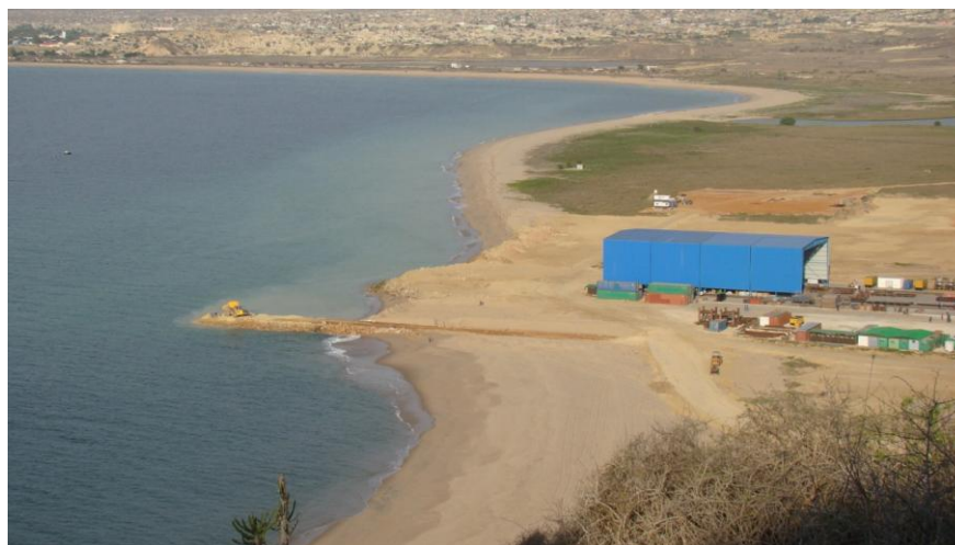
Figura 23 – Vista geral da obra. Novembro de 2008
