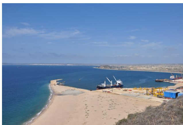
Figura 32 – Vista geral da obra. Novembro 2010
