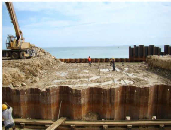
Figuras 25 e 26 - Início da cravação da cortina principal do Cais 1 (Fev. 2009) e instalação de tirantes (Março 2009).
