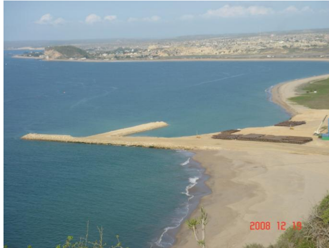
Figura 24 – Vista geral da obra. Dezembro de 2008
