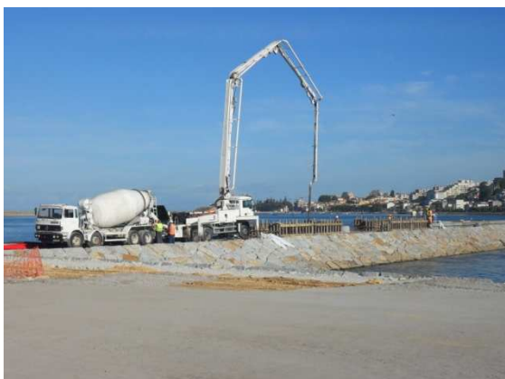
Fotografia 10 – Bombagem de betão
