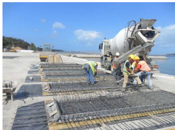
Fotografia 29 – Betonagem de pré-lajes
