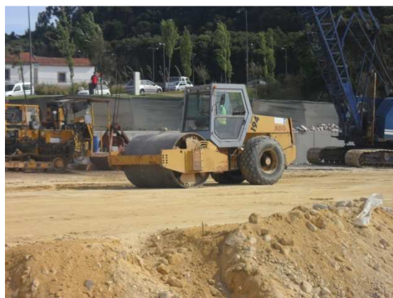
Fotografia 19 – Compactação com cilindro
