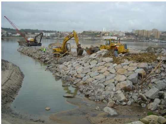
Fotografia 8 – Descarga com pá e revestimento
