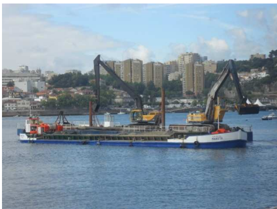
Fotografias 24 e 25 – Carga de batelões com escavadoras apoiadas em plataformas flutuantes
