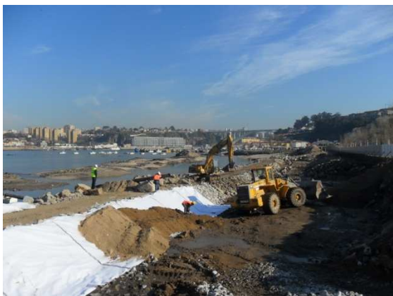
Fotografia 16 – Colocação de geotêxtil e aterro
