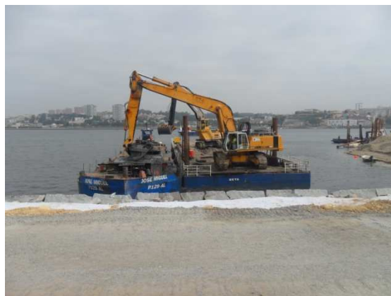
Fotografias 24 e 25 – Carga de batelões com escavadoras apoiadas em plataformas flutuantes
