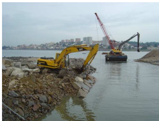
Fotografia 7 – Dragagem e enrocamentos
