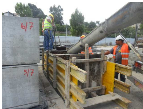
Fotografia 32 – Betonagem dos blocos laterais
