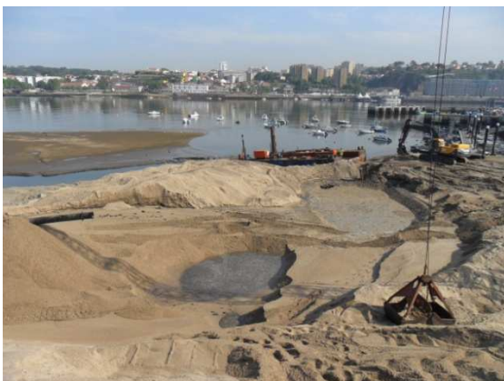
Fotografia 28 – Execução de aterro
