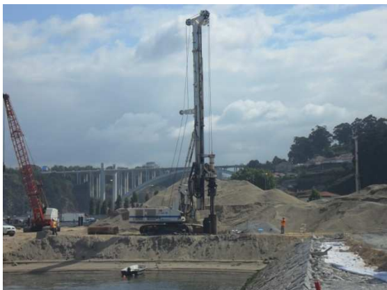
Fotografia 30 – Furação para estacas
