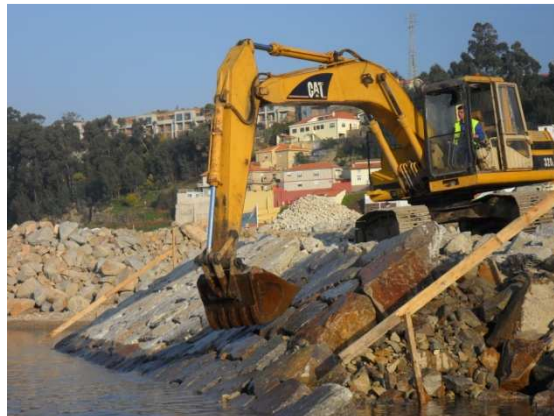
Fotografia 13 – Camada de revestimento
