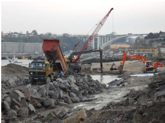
Fotografia 12 – TOT sobre geotêxtil
