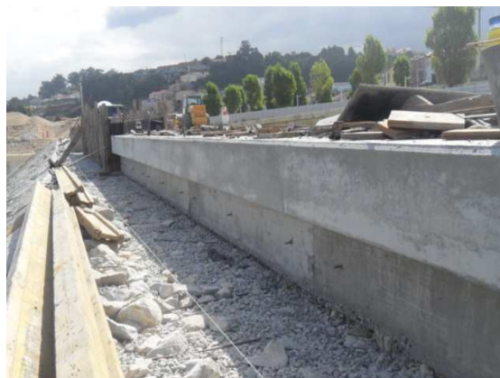
Fotografia 21 – Coroamento da retenção
