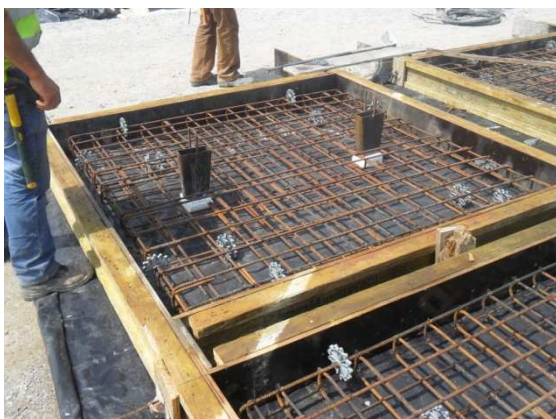
Fotografia 31 – Cofragem das lajetas
