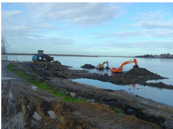
Fotografia 6 – Escavação e descarga de TOT
