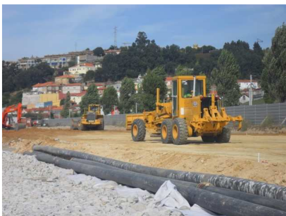
Fotografia 18 – Espalhamento de saibro
