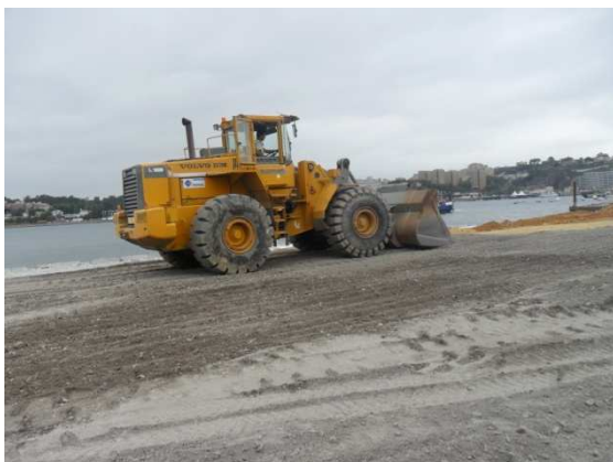
Fotografia 20 – Colocação de tout-venant
