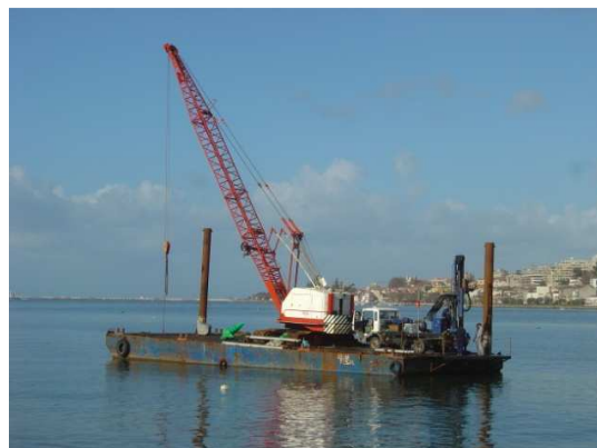
Fotografia 3 – Campanha geotécnica (CPTU)
