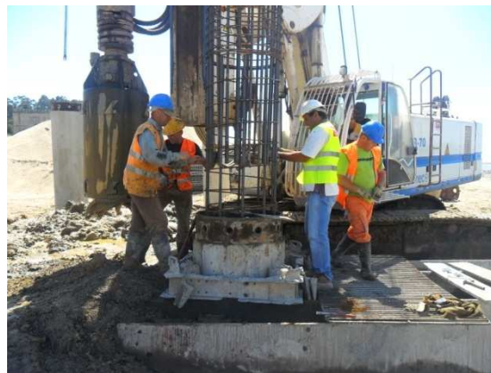
Fotografia 31 – Colocação de armaduras
