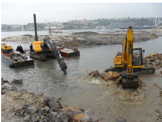
Fotografia 14 – Escavação com ripper
