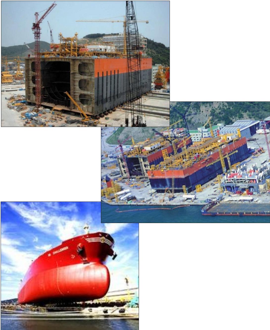
Figura 15 - Construção sobre o terrapleno
