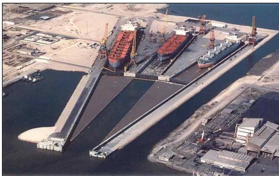
Figura 19 - Estaleiro da Mitrena - Vista geral do Hydrolift
