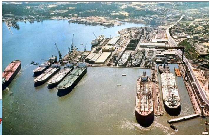
Figura 1 - Estaleiro da Margueira - Vista Geral
