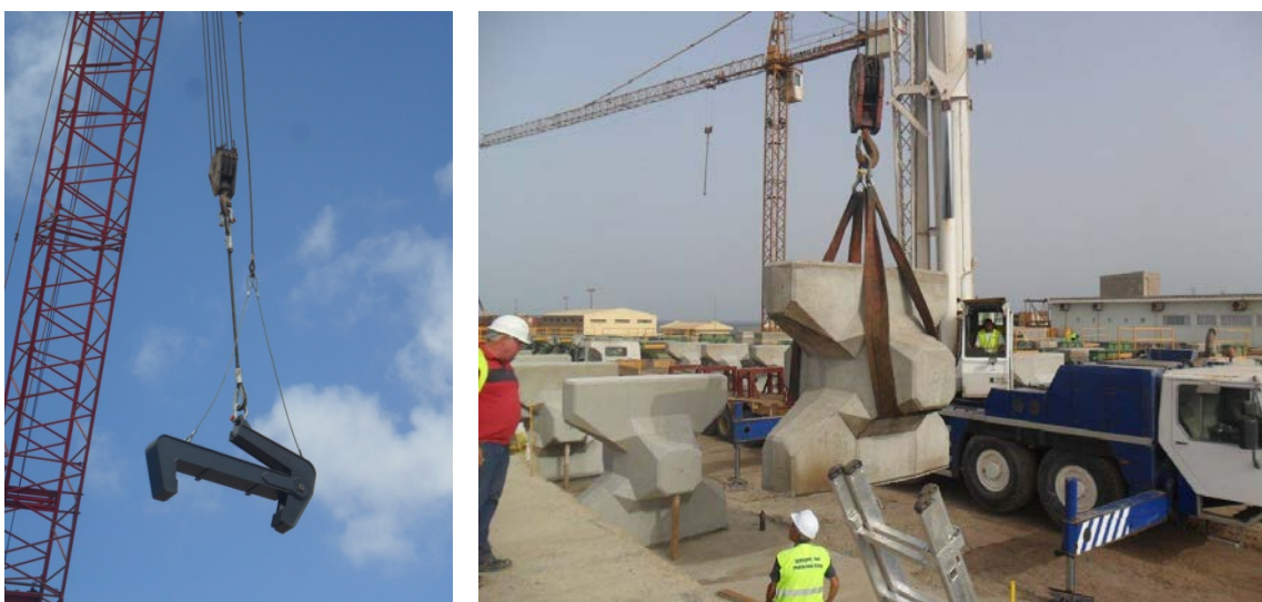
Figura 7. Pinça metálica de pressão para segurar os Cubos (esquerda) e fitas para segurar e suspender Accropode™ (direita).
