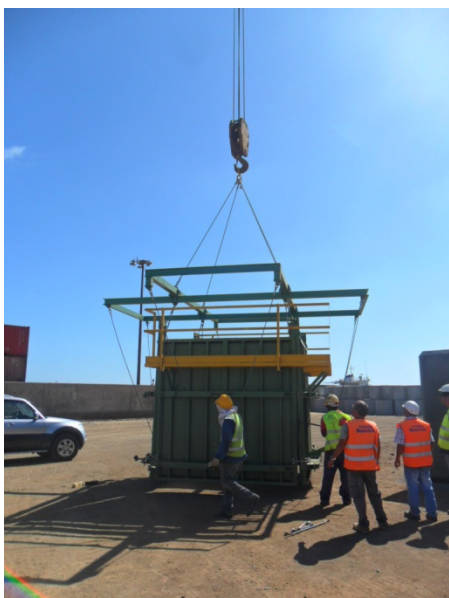
Figura 5. Cofragem para Cubos de betão (esquerda) e para de Accropode™ (direita).
