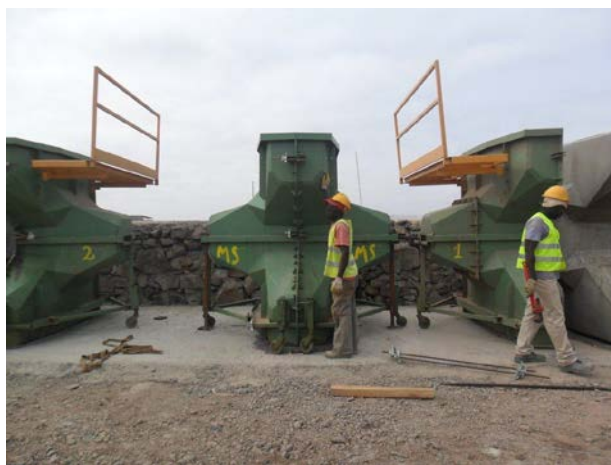
Figura 5. Cofragem para Cubos de betão (esquerda) e para de Accropode™ (direita).
