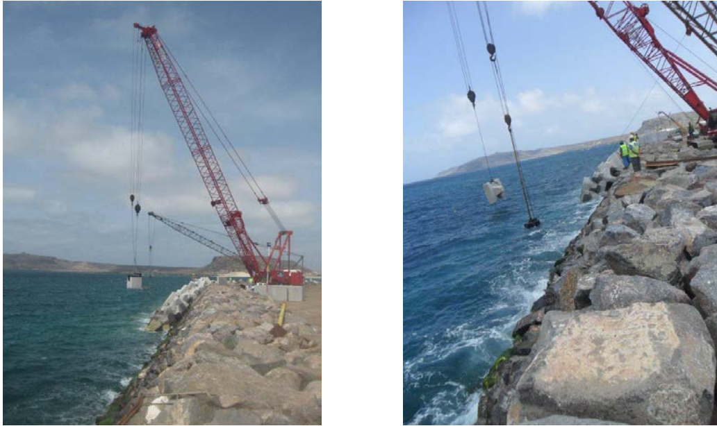
Figura 8. Colocação de Cubo (esquerda) e de Accropode™ (direita)
