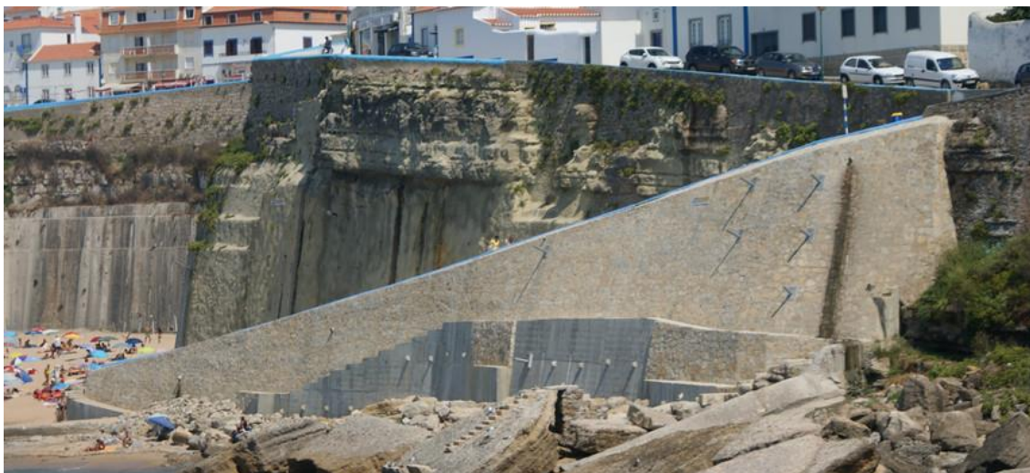
Figura 27 – Aspecto geral da rampa sul, após intervenção
