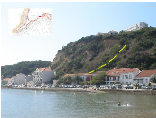
Figura 10 – Infografia onde se assinala o escorregamento incipiente.
