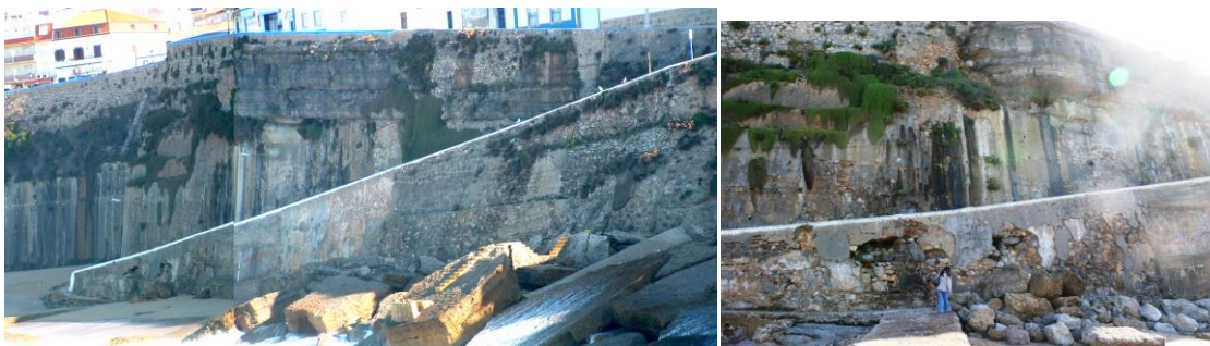
Figura 23 – Aspecto de muro de suporte da rampa entre 2005 e 2011.
