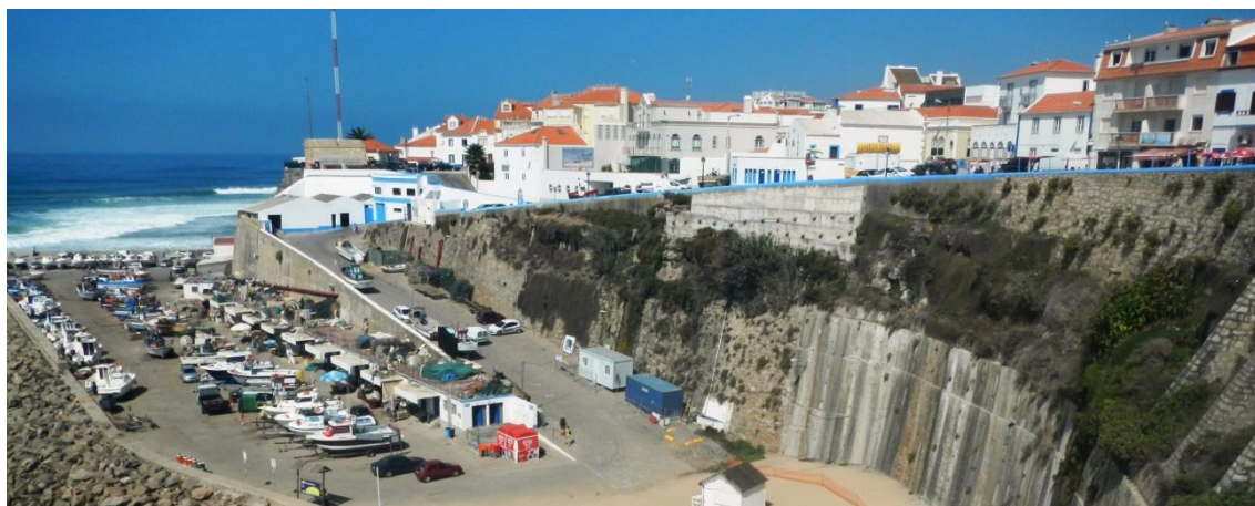
Figura 18 – Aspecto do muro adjacente à Capela de Sto António, antes da intervenção.
