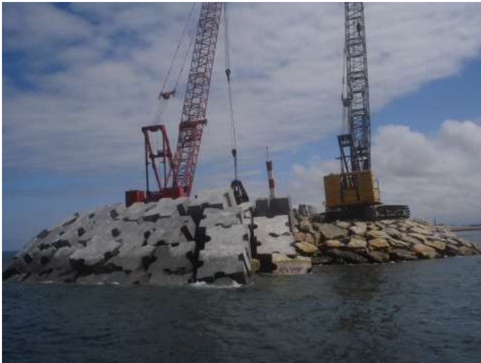
Figura 14 – Execução do manto de protecção da cabeça
