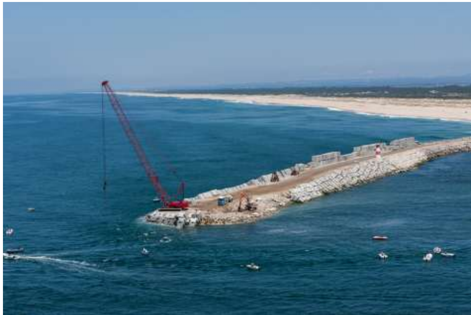
Figura 14 – Execução dos mantos de protecção (tronco e cabeça)
