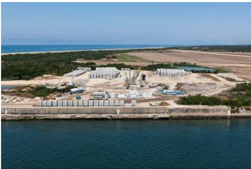
Figura 8 – Estaleiro de prefabricação
