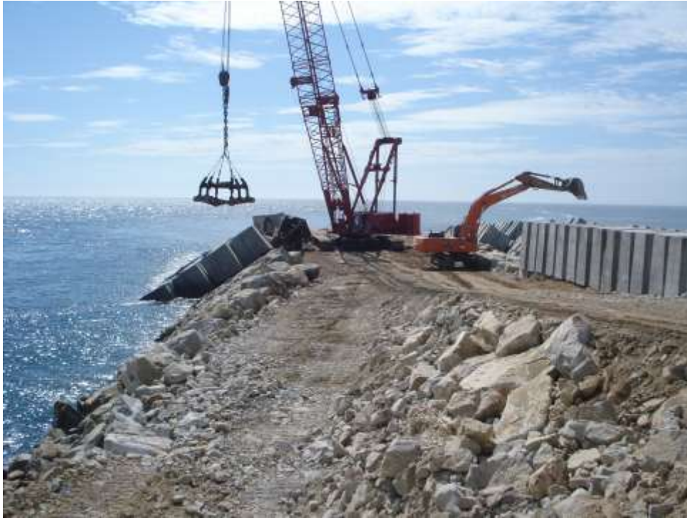
Figura 11 – Execução do núcleo, dos submantos e dos mantos de barlar e sotamar
