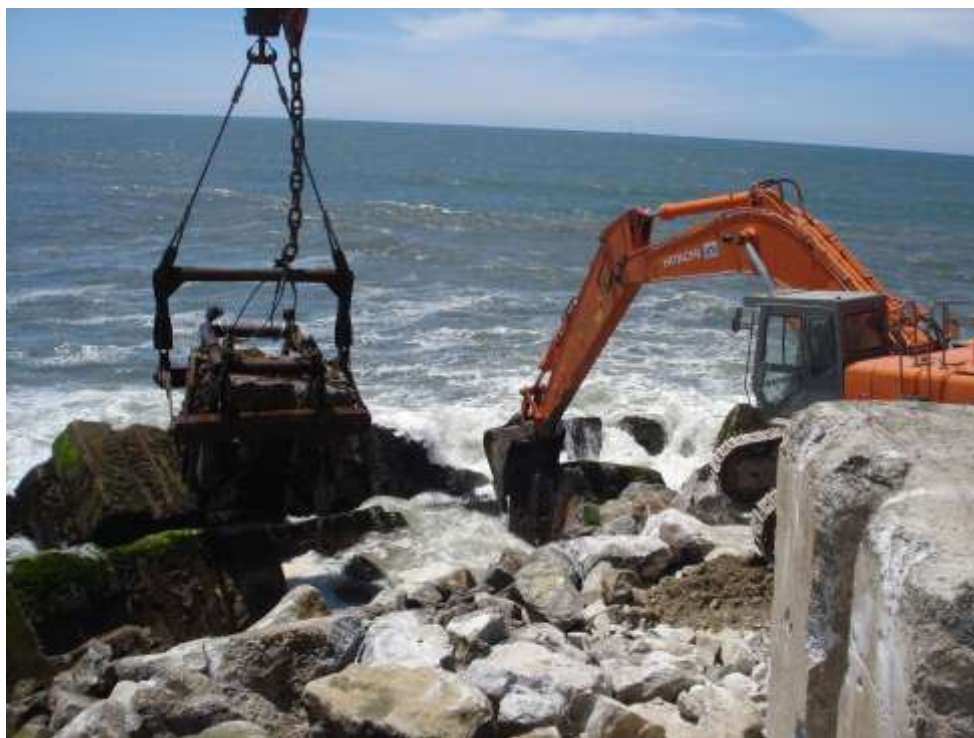
Figura 7 – Remoção de blocos e de enrocamentos na cabeça do molhe existente
