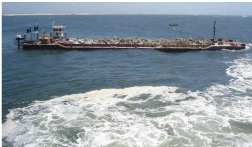
Figura 10 – Transporte de enrocamentos por via marítima
