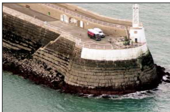
St Catherine's Breakwater (Inglaterra)
