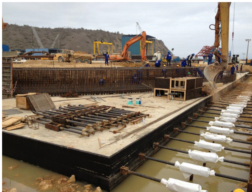
Figura 9 – Vista da laje da plataforma de alívio e dos tirantes de ancoragem da cortina do cais.
