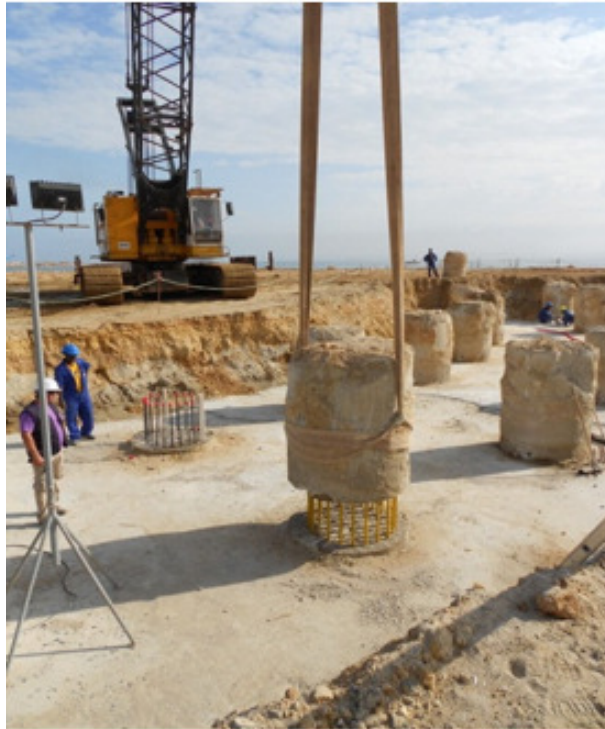
Figura 6 – Saneamento da cabeça das estacas.
