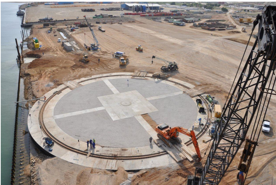
Figura 14 – Estrutura de fundação da HLC após terminados os trabalhos.
