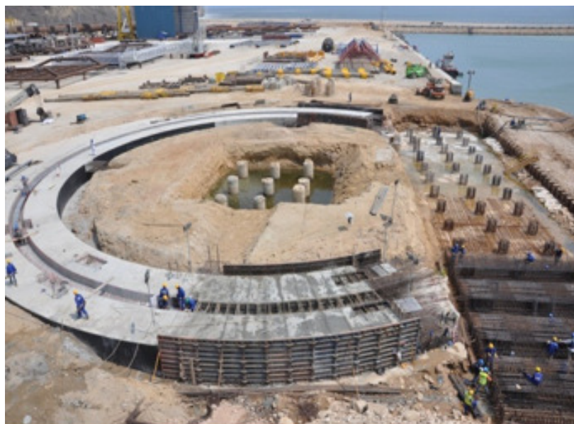
Figura 7 – Construção da laje da plataforma de alívio e da parte do lado de terra do maciço de fundação do caminho de rolamento da grua.
