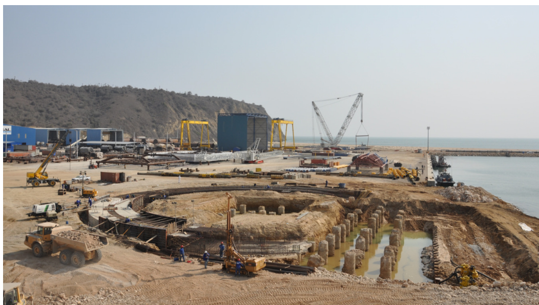
Figura 8 – Após construção das estacas da plataforma de alívio. Construção da parte do lado de terra do maciço de fundação do caminho de rolamento da grua.
