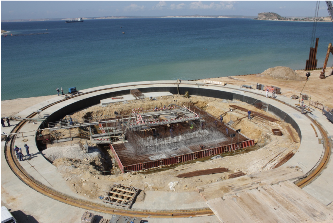
Figura 13 – Construção do maciço de fundação do apoio central da grua.
