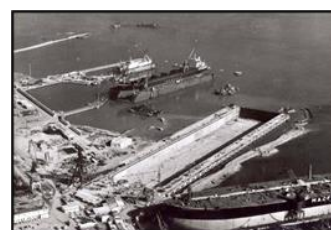
Figura 14 – Vista durante a construção
