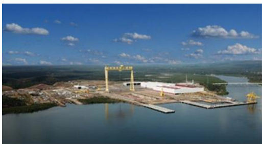
Figura 33 – Vista aérea após a suspensão da obra
