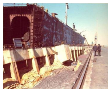
Figura 7 – Vista da parede desmoronada
