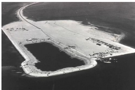
Figura 16 - Dragagens, aterros e proteções marginais
