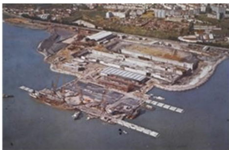
Figura 2 – Vista das obras da primeira fase durante a construção
