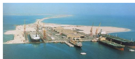
Figura 18 - O ASRY em operação após construído, em 1977
