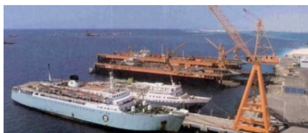
Figura 20 - Vista do JRSY em operação após construído em 1983
