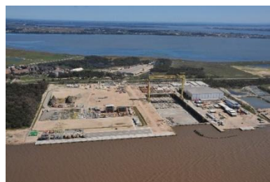
Figura 28 – O ERG após construído em 2010
