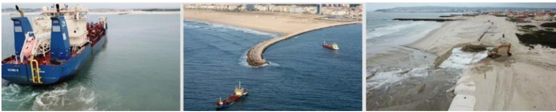
Figura 4. Figueira da Foz. Exemplo de sistema móvel de TAA baseado em dragagem regular. A deposição é feita a sotamar na faixa ativa do transporte e/ou com métodos auxiliares em terra.
