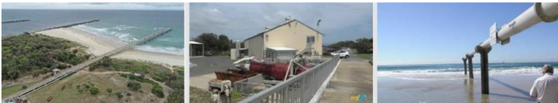
Figura 1. Gold Coast Seaway, na Austrália. Vista geral, edifício de controlo e descarga superficial.
