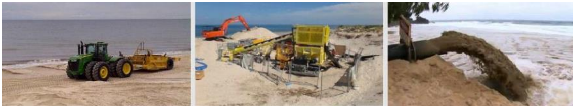
Figura 2. Adelaide-AU, praias urbanas. Exemplo de sistema misto de TAA com recurso a tratores-raspadores, sistema emulsionador de areias e circuito hidráulico de descarga.
