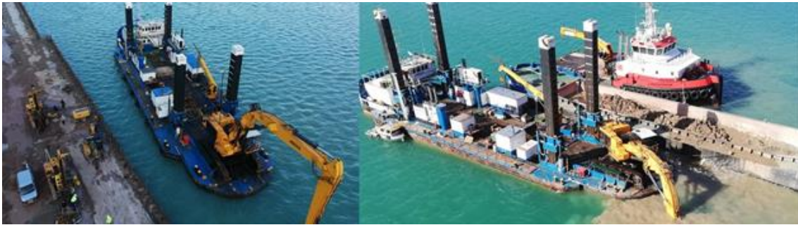
Figura 15 – Dragagem que atingiu profundidades máximas de 8.0m, até à cota -18.00 ZH
