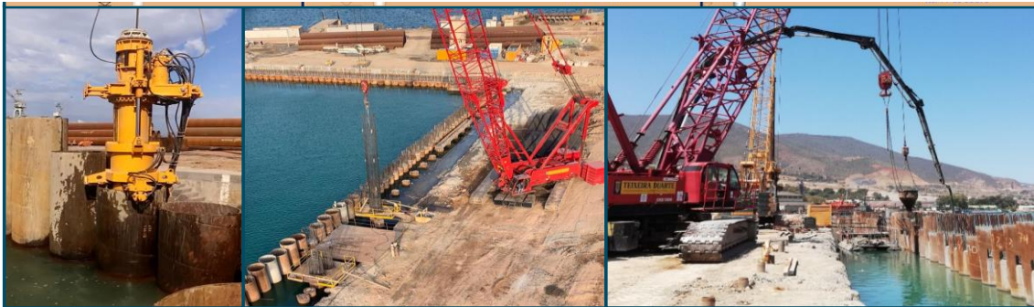
Figura 13 – Imagens das operações para execução das estacas moldadas da cortina de recalce
