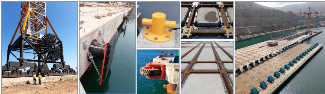
Figura 18 – Imagem de uma grua rolante, de alguns equipamentos de cais, da rede de carris e dos componentes do sistema de suspensão
