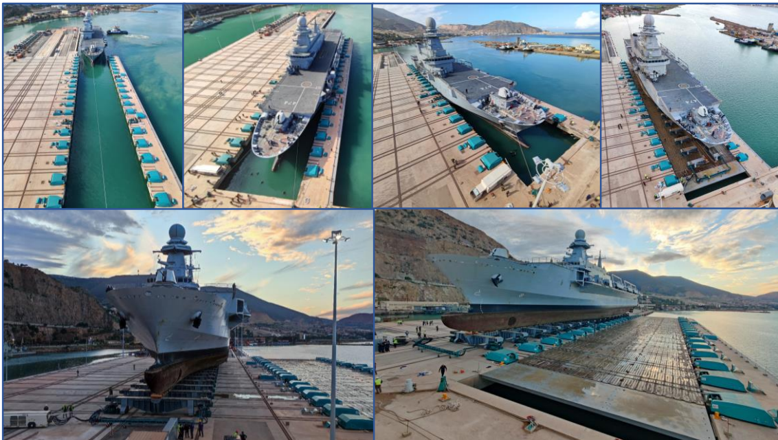
Figura 21 – Imagens do sistema em operação ilustrando a sequência da aproximação, elevação e transferência de um navio de 8500T para uma zona de estacionamento
