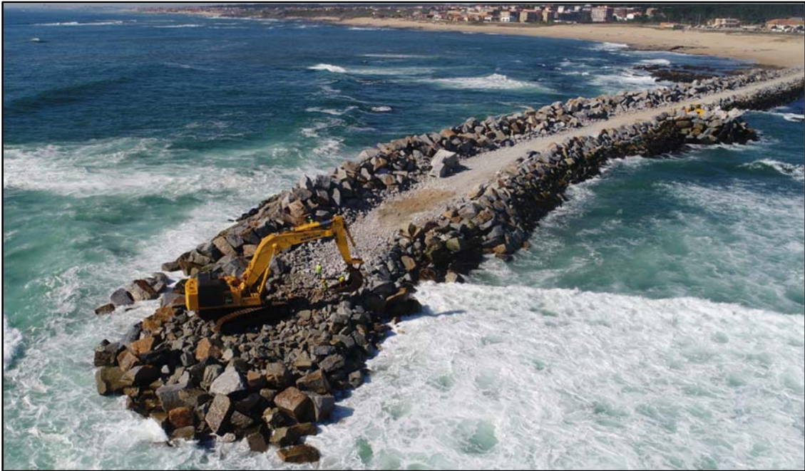
Figura 6. Frente dos trabalhos. Agitação marítima frequente
