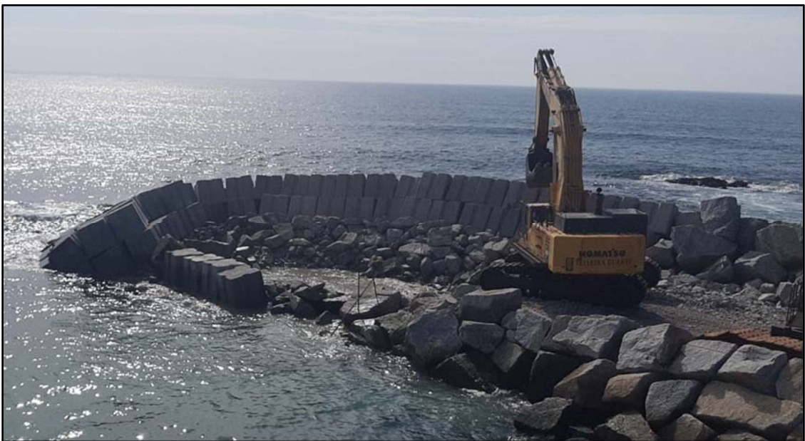
Figura 9. Construção da cabeça de proteção
