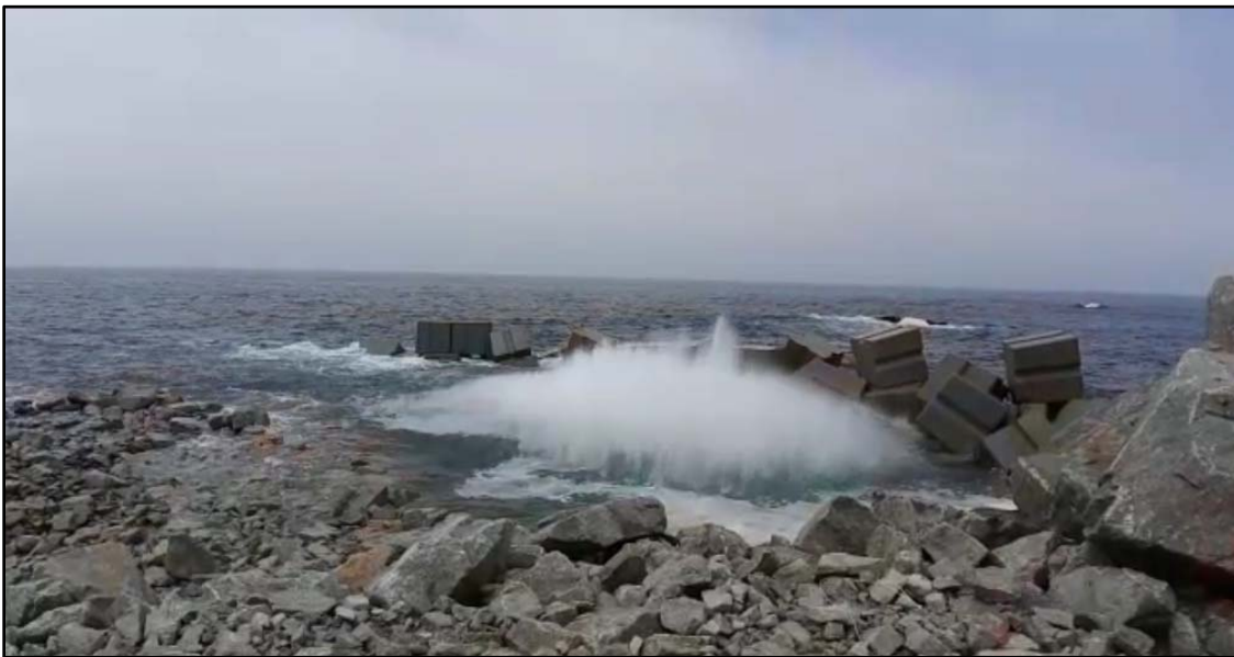
Figura 5. Pega de fogo para abertura da vala de fundação dos Antifer
