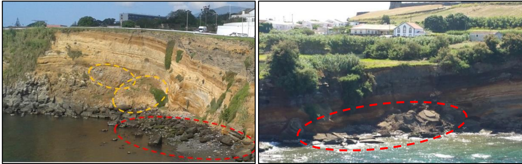
Figura 3. Fotos de Escorregamentos (laranja) e desmoronamentos (vermelho).
