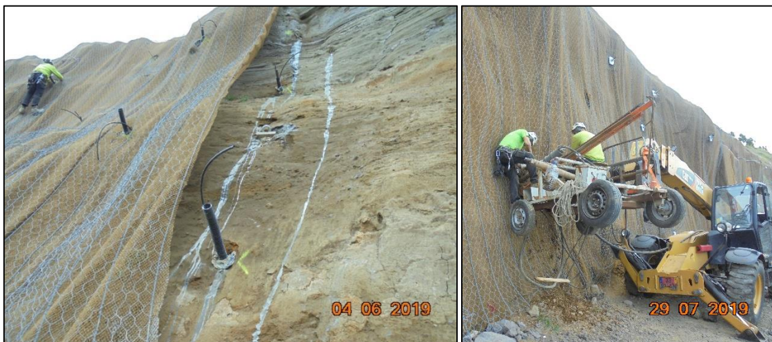
Figura 17. Fotografias da instalação das redes e das pregagens.
