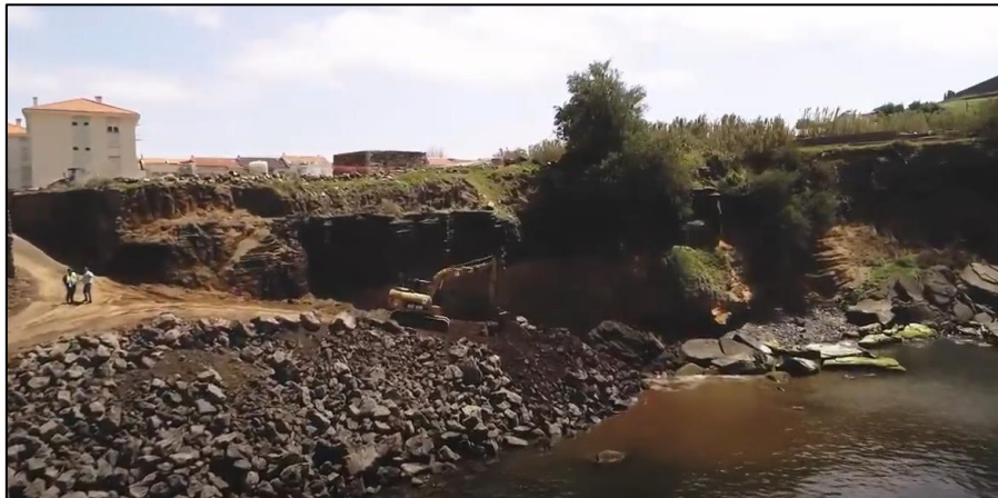
Figura 14. Construção da proteção marítima.
