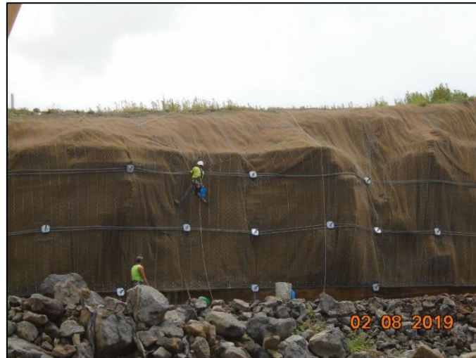
Figura 12. Fotografia de uma fase final da instalação do sistema de estabilização.
