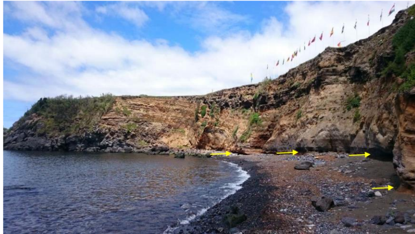
Figura 6. Vertente Oeste da Baía do Fanal, observando-se taludes com inclinação sub-vertical e cavernas de erosão por ondas na base das arribas que induzem a instabilidade.
