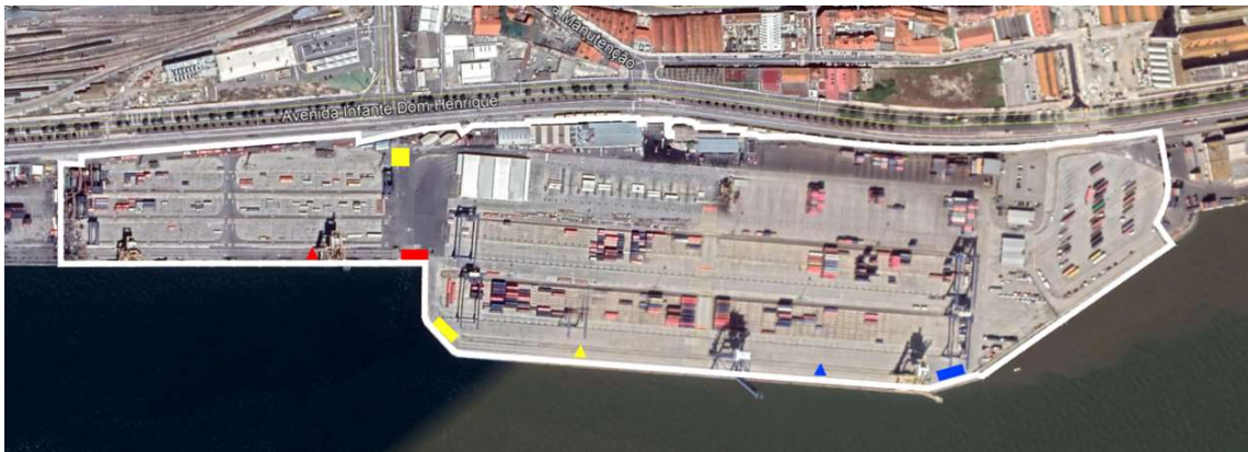
Figura 26 – Implantação de equipamentos no Terminal de Contentores de Santa Apolónia (SOTAGUS)
