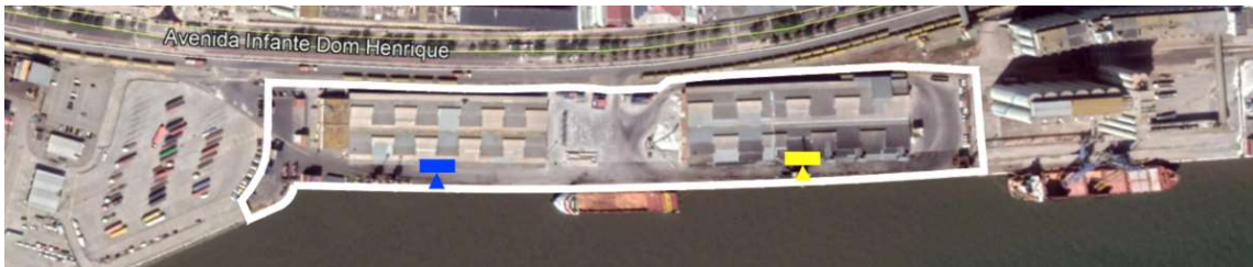
Figura 27 – Implantação de equipamentos no Terminal Multiusos do Beato (TMB)
