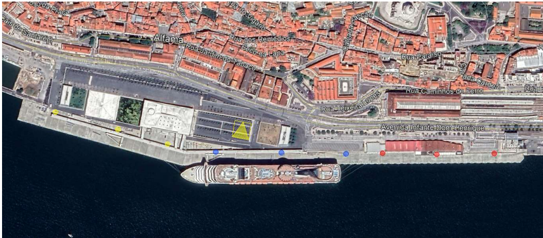
Figura 22 – Implantação de equipamentos no Terminal de Cruzeiros de Lisboa (LCP)
