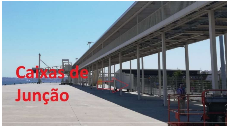
Figura 20 – Localização prevista para as caixas de conexão
