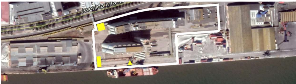
Figura 28 – Implantação de equipamentos no Terminal de Granéis Alimentares do Beato (SILOPOR)
