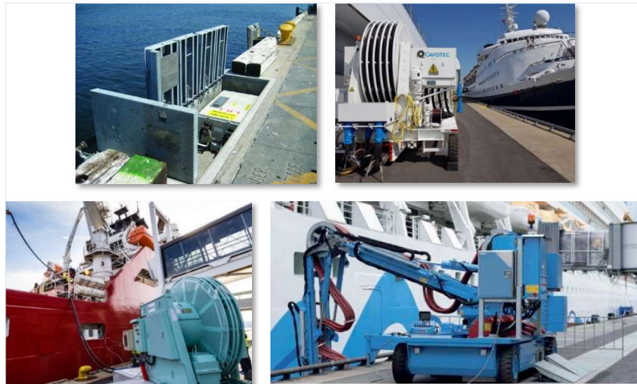
Figura 5 - Sistemas diversos de Cable Management System. Da esquerda para a direita: Cavotec AMP Vault, Cavotec AMP Mobile, Cavotec AMP Reel, Siemens Siharbor Caddy [32] [33]
