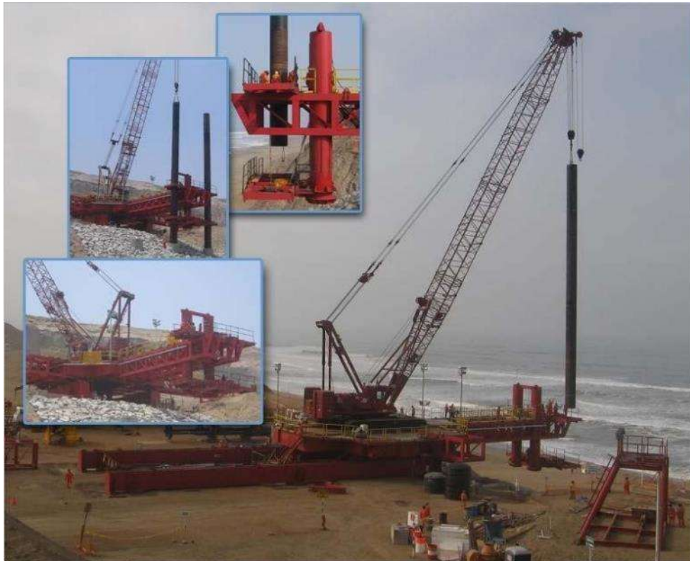
Figura 4 – Ilustração do arranque do cantitravel para construção de Ponte de Acesso
