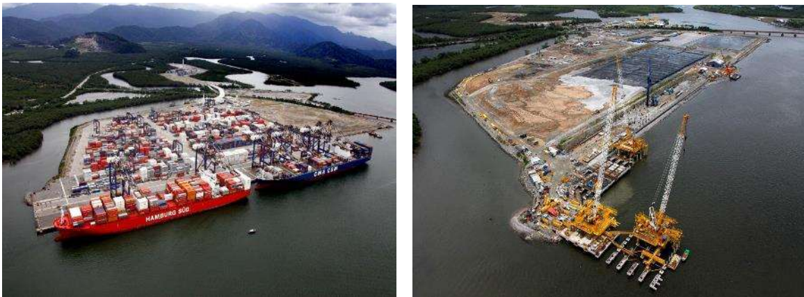
Figura 8 e 9: Vistas aéreas do terminal Embraport durante a construção e já concluído
