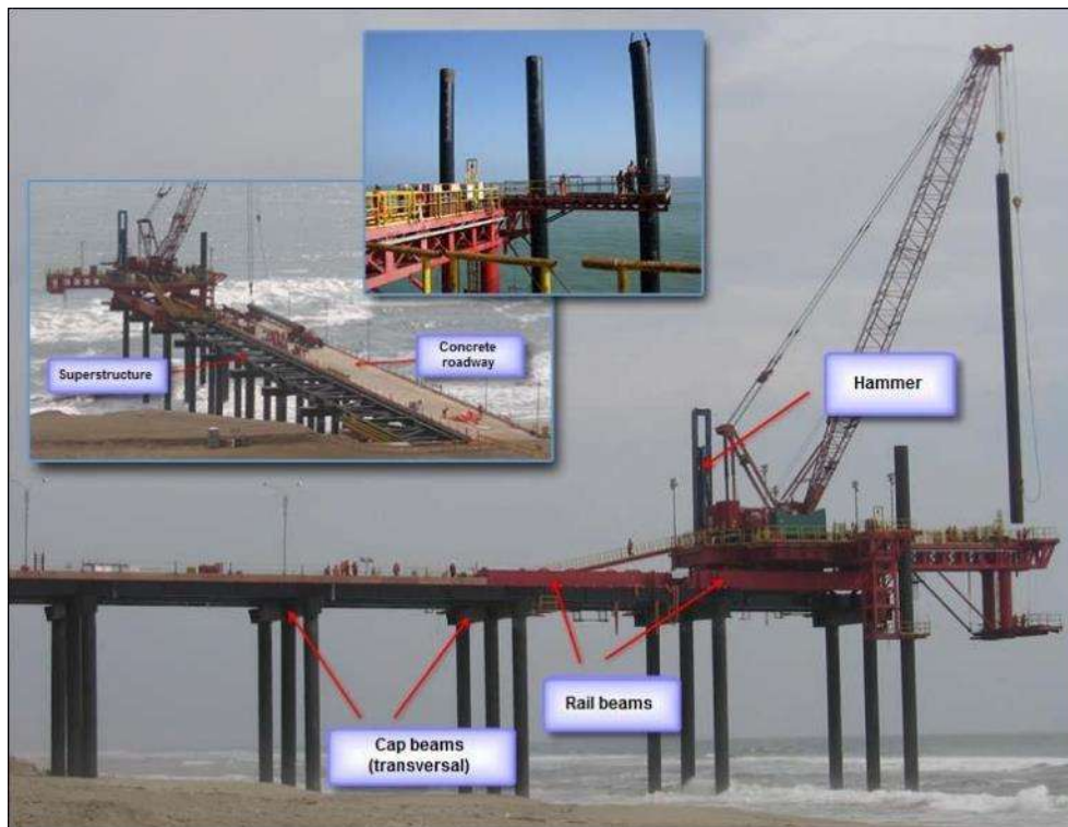
Figura 5 – Cantitravel sequência típica – Ponte de Acesso
