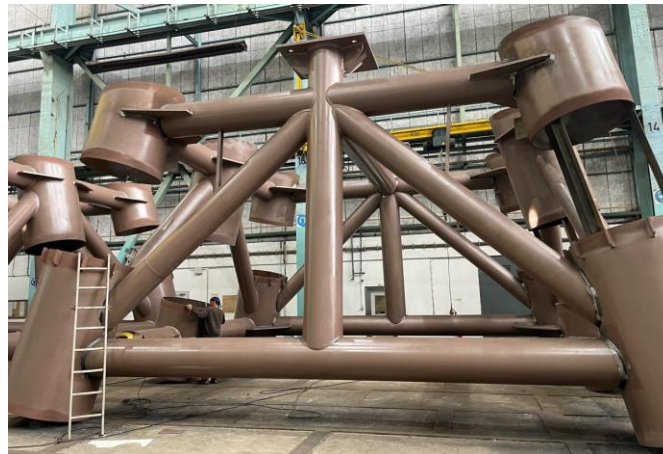
Figura 8 – Superestrutura dos Duques d'Alba de amarração em pré-fabricação no estaleiro.
