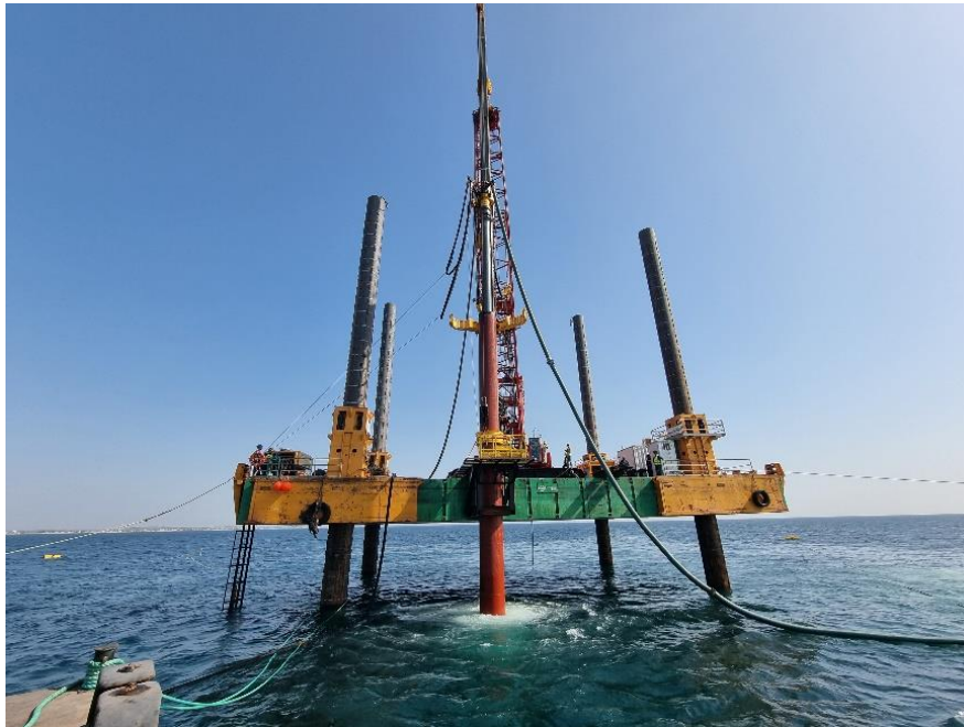
Figura 16 – Perfuração e instalação da primeira estaca da plataforma.
