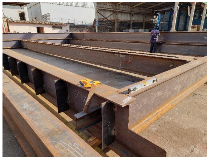
Figura 11 – Superestrutura da plataforma em pré-fabricação em estaleiro em Dakar.
