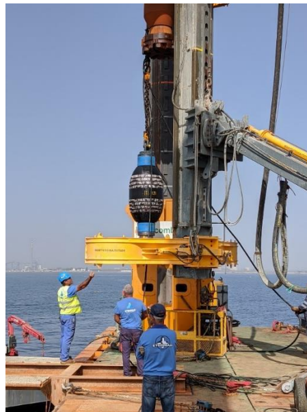
Figura 17 – Colocação de obturador na extremidade inferior da estaca.
