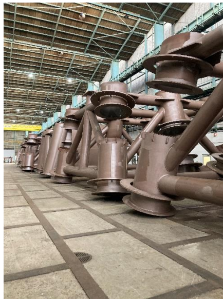
Figura 13 – Superestruturas de Duques d’Alba
