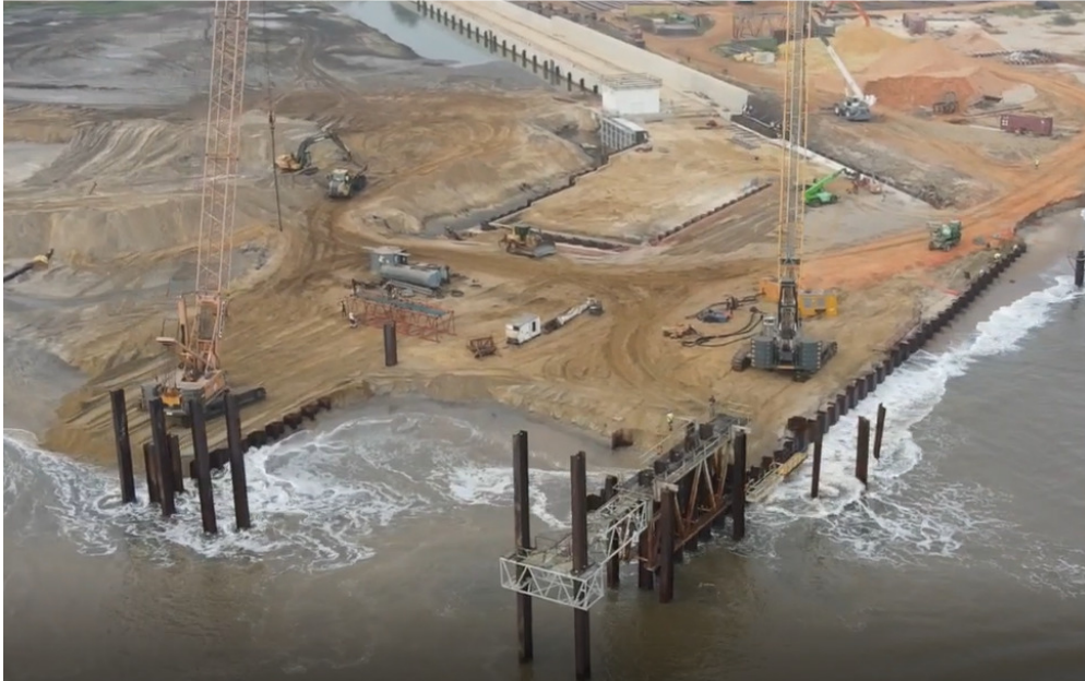
Figura 14 – Construção da secção mais larga do quebra-mar.
