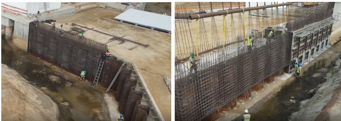
Figura 15 – Construção de uma viga de coroamento (à esquerda) e do muro-cortina (à direita).
