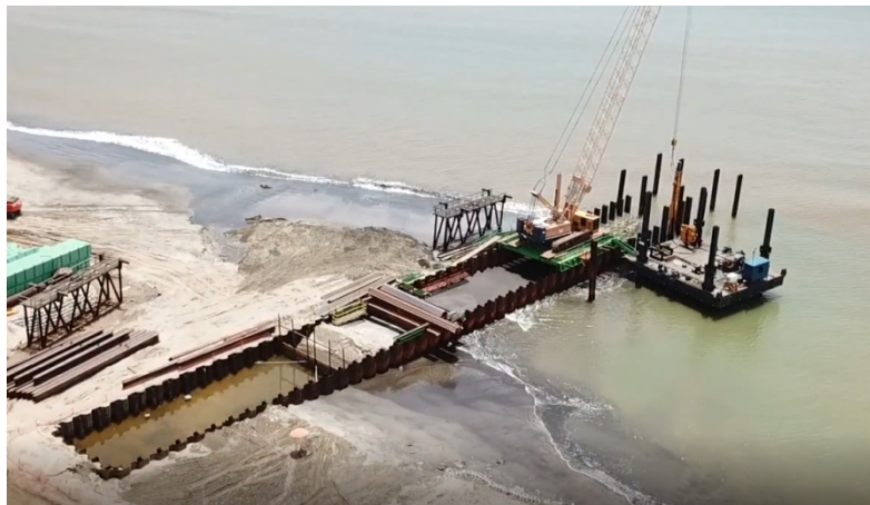
Figura 13 – Construção da secção mais estreita do quebra-mar.
