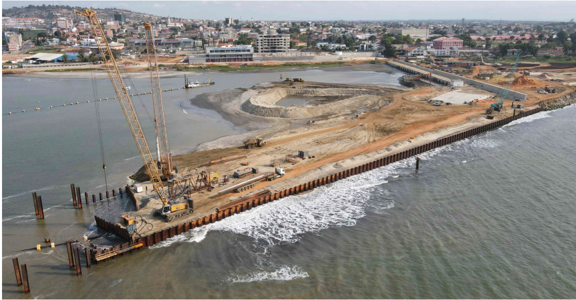
Figura 16 – Vista da frente de trabalho aproximando-se da extremidade do quebra-mar.
