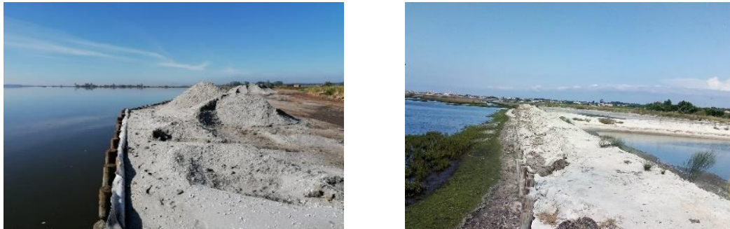
Figura 8. Exemplo de uma zona de depósito limitada por paliçadas nas duas figuras à direita
