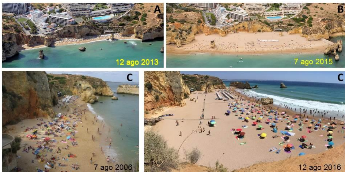
Figura 3. Evolução da praia D. Ana, antes (A, C) (12 agosto 2013) e após a alimentação artificial (B, D) (7 agosto 2015). Em baixo, note-se o efeito de migração natural dos utentes no sentido do plano de água, afastando-se das faixas de perigo (zonas potencialmente afectas por eventual movimento de massa das arribas).
