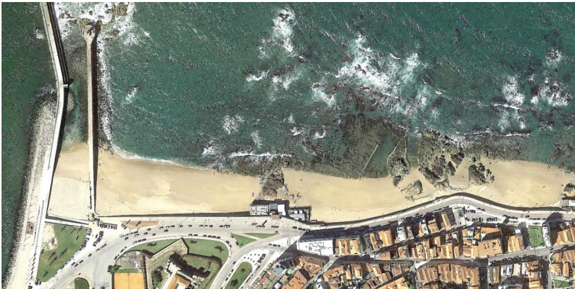
Figura 3 – Imagem aérea da Praia do Carneiro evidenciando a localização dos afloramentos rochosos (fonte: APDL): 9 de maio de 2013.
